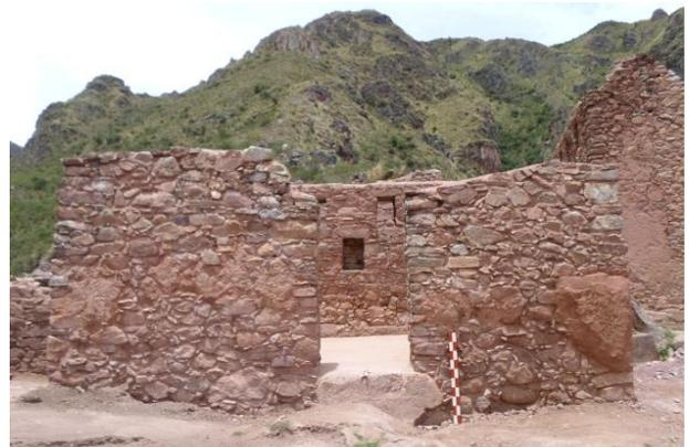
hornacinas de forma trapezoidal de las cuales una de ellas se encontró colapsada y dos ventanas en regular estado de conservación con pérdida de sus dinteles en la parte superior. También podemos observar revoques de enlucidos en el interior y exterior del recinto en regular estado de conservación.
