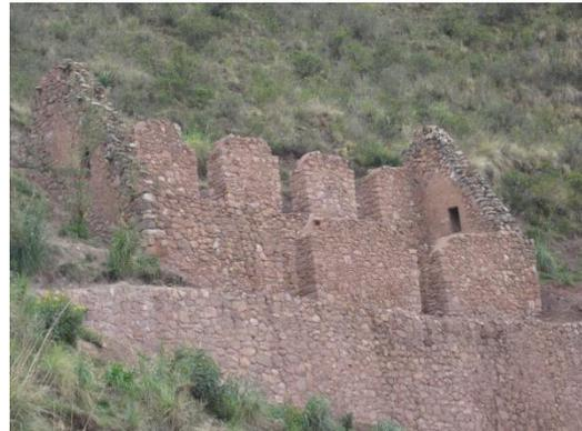
oeste donde se realizaron los trabajos de restitución, con dos ventanas orientadas al norte y sur con dinteles de madera aliso. Al interior del recinto se observa revoque de enlucido.
