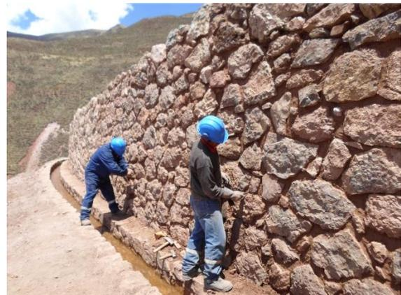
**Foto 62.-** Emboquillado, Muro de Contención 02 - Este.
