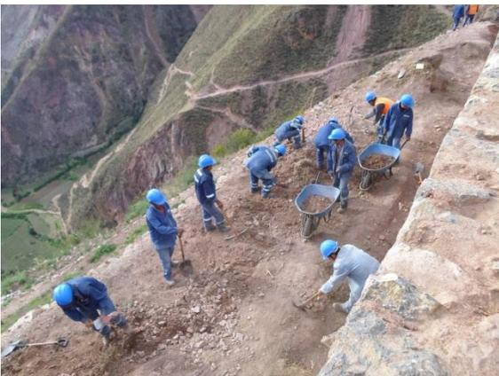
**Foto 34.-** Eliminación de la plataforma del M.C. 03.
