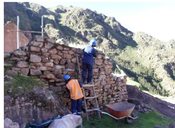
**Foto 06.-** Fliminación de maleza del Muro de Conexión.
