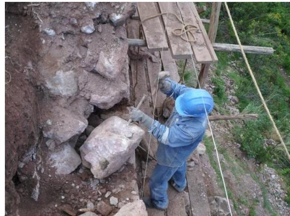
**Foto 21.-** Canteado de piedra para el Muro Perimétrico.
