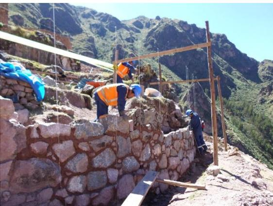
**Foto 51.-** Restitución del Muro de Contención 02.- Este.
