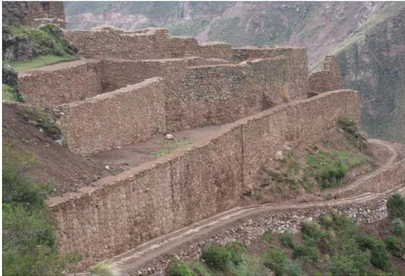
**MUROS PERIMETRICOS 01 Y 02.-** Estos muros perimétricos se ubican en el lado oeste de la Zona Arqueológica, sobre una plataforma - andén de sostenimiento. Durante el proceso de intervención se realizó trabajos de restitución y consolidación de muro. Así poder recuperar la originalidad de los paramentos.
