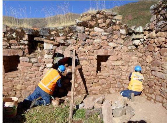
**Foto 48.-** Restitución en la Kallanka – Muro sur.
