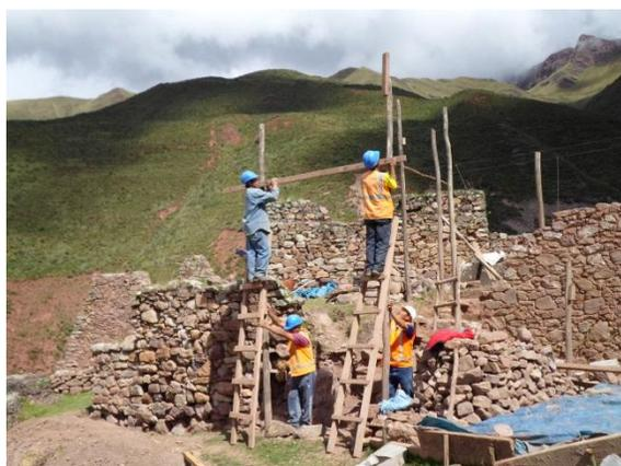
**Foto 07.-** Colocado de Balizas en el Muro de Conexión.
