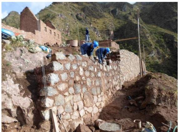
**Foto 52.-** Restitución del Muro de Contención 03 -Este
