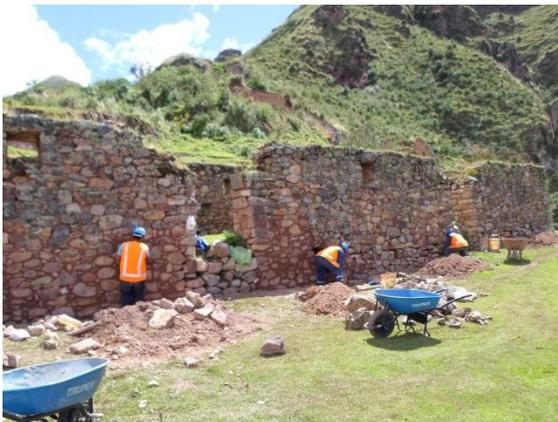
**Foto 61.-** Emboquillado, muro este – exterior, Kallanka.
