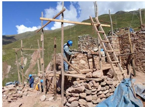
**Foto 50.-** Restitución de muro – Muro de Conexión..
