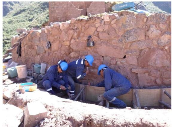
**Foto 55.-** Restitución de canal a pie del M. Perimétrico.
