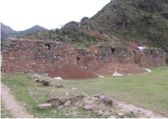
construida con piedras canteadas unidas con mortero de barro, con presencia de dos vanos de acceso que dan a un patio central, al interior presenta veintiséis hornacinas de forma rectangular, de las cuales una de las hornacinas fue restituida y siete ventanas de forma trapezoidal, distribuidas simetricamente con dinteles de piedra (interior).
