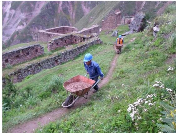
Foto 14.- Acarreo de mortero para el asentado de muro.
