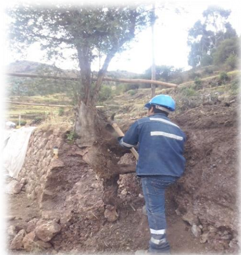
Figura N°07: Proceso de relocizacion
