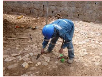
Imagen N° 57 proceso de limpieza de la calzada del camino UE- 03
