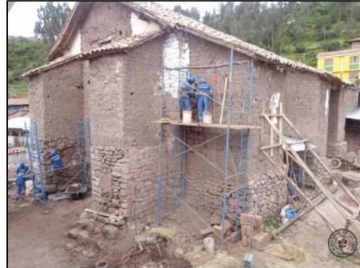
*Detalle de los trabajos de calzadura en los sobrecimientos, cimienos y muros del Templo.*
