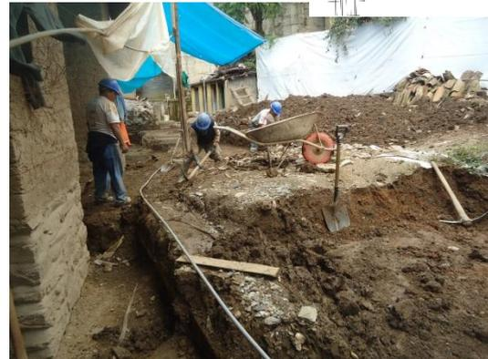
**OE4.2.2. PROCESO DE CRIBADO DE TUBERÍA DE PVC SAL DE 6” (M).**
