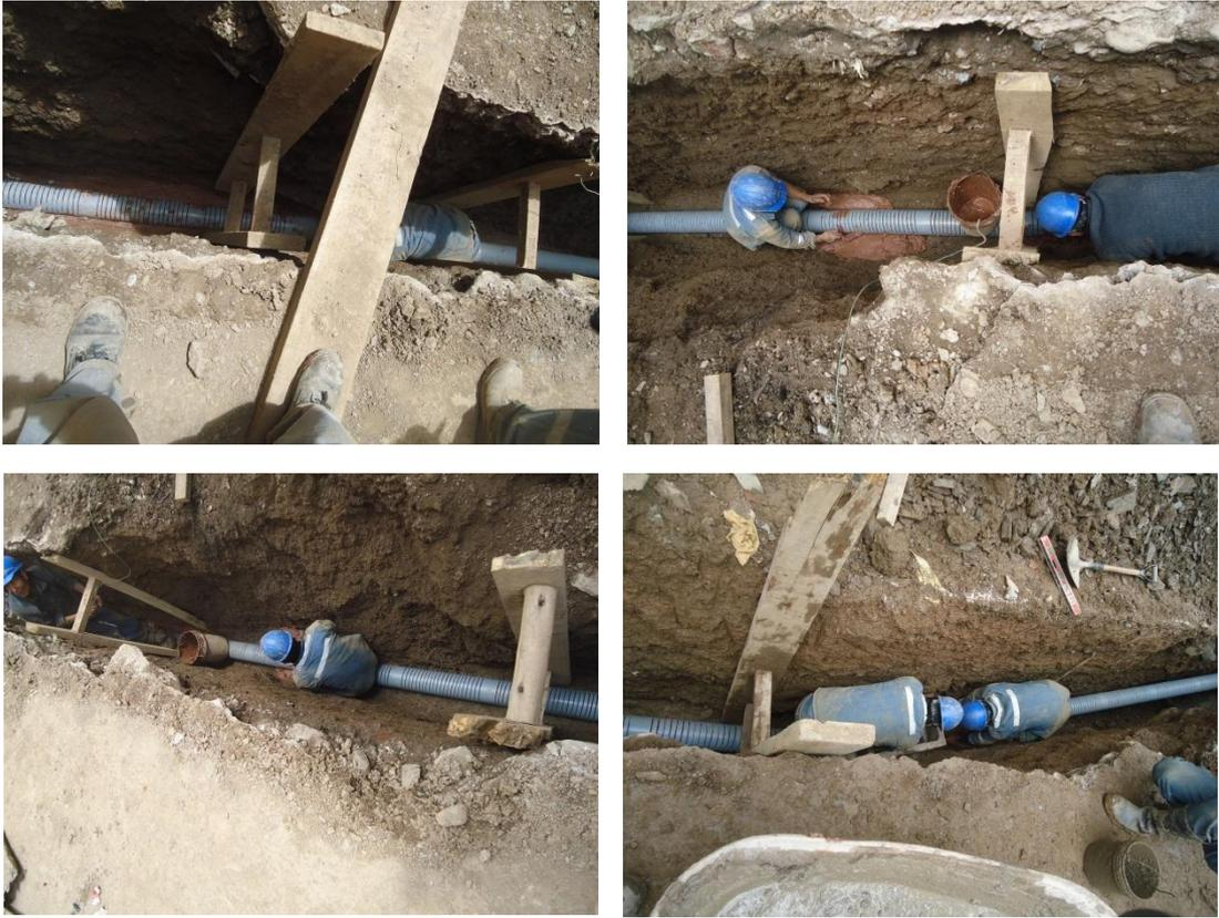
**OE4.2.4 RELLENO CON MATERIAL DE FILTRO (granular seleccionado de 1/2”) (M3).**
