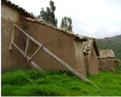
El muro del Evangelio externamente está, constituido cimientos, y sobrecimientos de piedra y con mortero de barro, muros de adobe, un pequeño alero sobre canes de madera rolliza. Adosado al muro del evangelio se ubican dos contrafuertes y un vano actualmente tapiado, así también esta adosado a este muro el ambiente de la sacristía.
