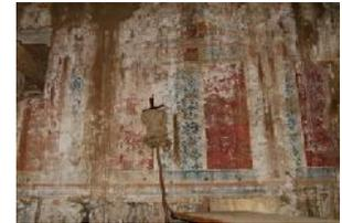
filtrada por el techo lo que produce el desprendimiento del mortero y los emboquillados, demás también la pérdida del remate del pintura mural en la cabecera de los muros por la cambio del techo.
