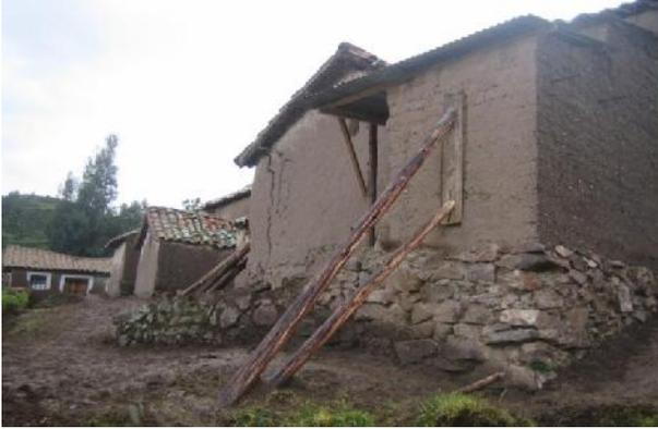
desapareciendo por su resistencia limitada en el mortero y con el tiempo están siendo soterrados provocando humedad y presencia de eflorescencias al interior.
