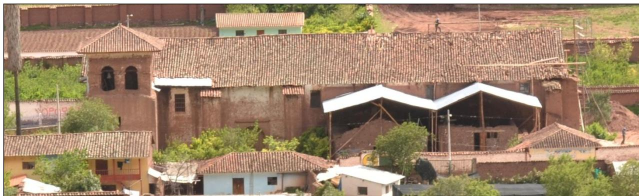
La configuración estructural de la fachada se genera por la confluencia de espacios anexos al muro de la epístola como las capillas laterales y la adición de construcciones contemporáneas para uso de depósito y vivienda, además de la inclusión de contrafuertes, dos de los cuales enmarcan el acceso a la capilla abierta actualmente clausurada, y otra flanqueando el muro testero siendo la torre el elemento de mayor envergadura en toda la fachada.
