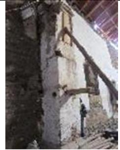
Consolidación de Abolsados y Puntos de Contención
