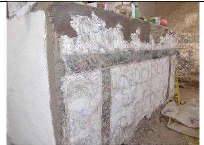
Restitucion del Enfoscado Con Mortero de Barro (Repellado), Restitución de Faltantes - Enlucidos
