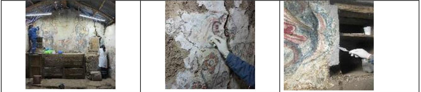
Consolidación de Abolsados y Restitucion del Enfoscado Con Mortero de Barro (Repellido)
