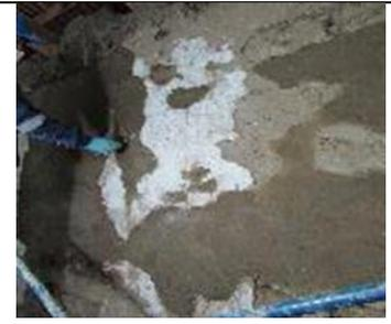
Restitucion del Enfoscado Con Mortero de Barro (Repellado)
