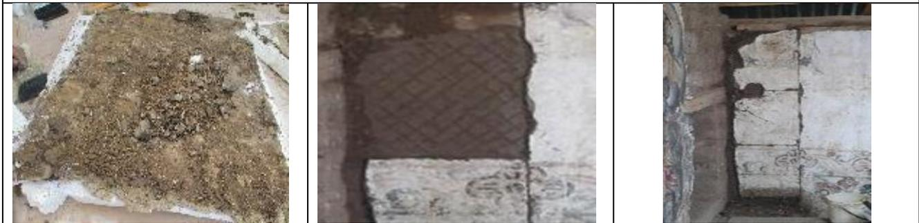
Desbastado y Liberación de Enfoscados y Montaje del Fragmento al Muro con Mortero Tradicional
