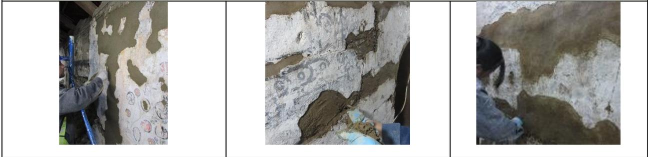
Restitucion del Enfoscado Con Mortero de Barro (Repellado)
