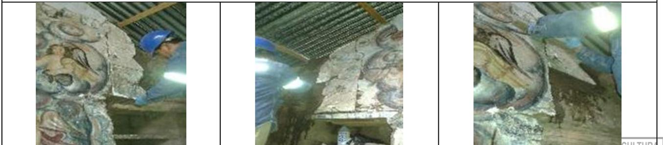
Montaje de Fragmentos Desmontados y Restitucion de Enfoscado con Mortero de Barro (Repellido)
