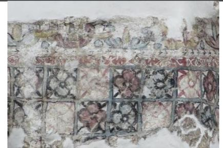
Restitucion del Enfoscado Con Mortero de Barro (Repellado), Restitución de Faltantes - Enlucidos
