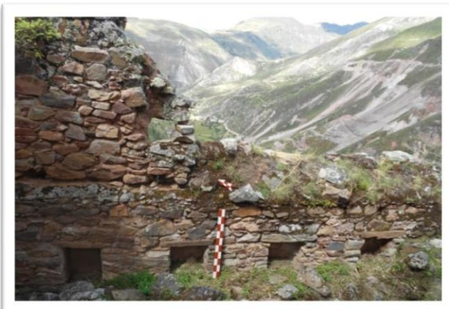
con dinteles de piedra, sobre aparejo de piedra simple; Segundo nivel la disposición de vanos y hornacinas siguen una secuencia lineal manteniendo correspondencia del eje horizontal y en profundidad mantiene relación con el ancho de muro con dinteles de piedra tallada.
