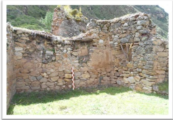
**RECINTO 06.-** Este recinto presenta dos niveles, dos vanos de acceso en el segundo nivel y en el primer nivel colapsado, los paramentos de este recinto se hallan en mal estado de conservación, donde el paramento del lado derecho se halla apuntalado para evitar el posible colapso total del hastial. La tipología constructiva de mampostería lítica y mortero de barro además del enlucido (barro y paja). En la primera planta se registran
