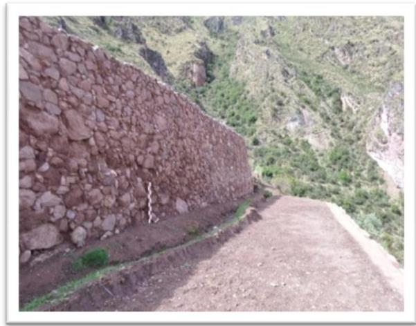
**RECINTO 01.-** Ubicado al este de la plaza principal, el cual se hallaba en regular estado de conservación debido a la degradación del mortero a en proceso de erosión, creando inestabilidad a nivel de cimentación por pérdida de piezas líticas. La tecnología con que fue construida se basa en una mampostería de piedra simple, una alturade
