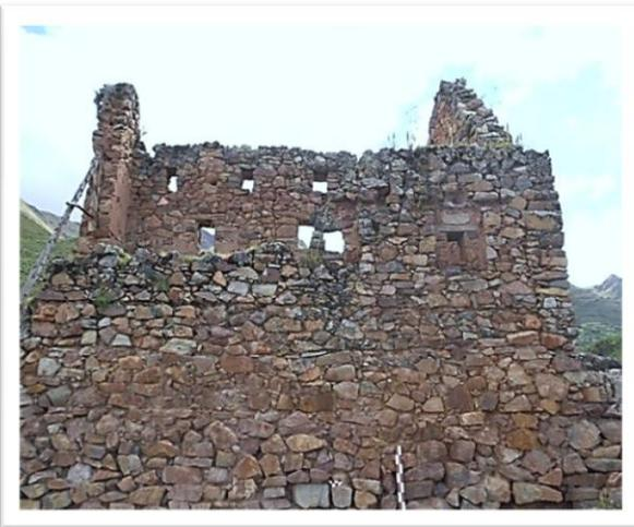
mampostería simple de piedras canteadas unidas con mortero de barro, se puede apreciar el enlucido interior (embarre) con mortero de barro mezclado con paja, Una de las peculiaridades del recinto es que consta de dos niveles, la tipología de vanos abiertos y cerrados.
