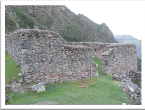
estado de conservación debido a la degradación del mortero primigenio esta se halla en proceso de erosión, creando inestabilidad a nivel de cimentación por perdida de piezas líticas. Cuenta con un vano de acceso en regular estado de conservación que da a un patio central, al interior se hallan hornacinas trapezoidales con
