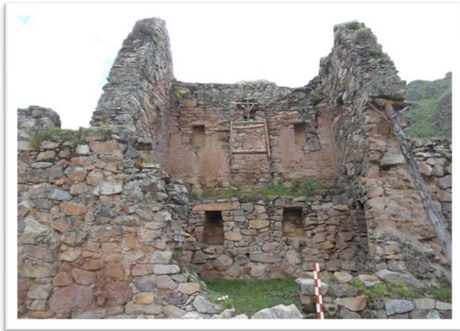
hornacinas interiores de formas trapezoidales, y una pequeña plataforma con hornacinas trapezoidales, y otra pequeña plataforma en dirección al ingreso al segundo nivel para el apoyo del entrepiso. Actualmente este se encuentra en pésimo estado de conservación debido a asentamientos diferenciales y por la magnitud de altura.
