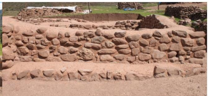
Veredas hacia el exterior de las estructuras para evitar que el agua de las lluvias se infiltre en los muros.
