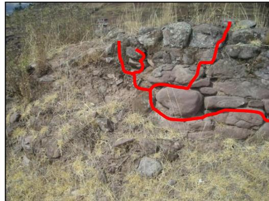
Fisuras provocadas por el enraizamiento de vegetación en el núcleo del paramento generando pérdida del material ligante y por consiguiente pérdida de elementos líticos.
