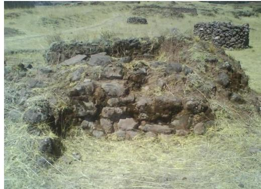
Pérdida de mortero original entre las juntas de los elementos líticos debido a la aparición de fisuras por donde fácilmente filtran las aguas pluviales hacia el núcleo del paramento degradando el material. Desplazamiento horizontal en segmentos de muro por acumulación de material orgánico sobre la superficie.
