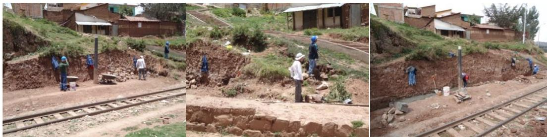
Vista 07, 08, 09.- Se realiza el corte manual del terreno hasta 1.75m en el sector de la línea férrea, para el armado del muro de contención.
