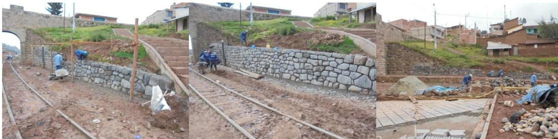
Vista 07, 08, 09.- Armado de muro de contención de concreto ciclópeo hacia la línea férrea, primer tramo de intervención se llega a una altura de 3.00m aproximadamente.
