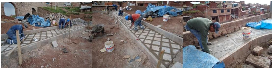
Vista 04, 05, 06.- Piso de loseta de piedra de 0.30 x 0.30m en veredas del sector del Estar IV. Y sellado de juntas con mezcla de cemento y arena fina
