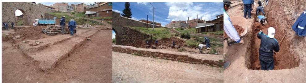
Vista 10, 11, 12.- Trabajos de movimiento de tierras como nivelación y apisonado manual cortes de terreno superficial, corte de terreno hasta 1.75m, corte de Talud N°2 y excavación de zanjas para armado de base de la estructura de muros contención N° 2 y 11.
