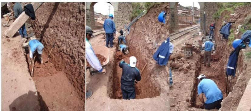
Vista 10, 11, 12.- Excavación manual de zanjas hacia la línea férrea, para la base del muro de contención o muro ciclópeo.
