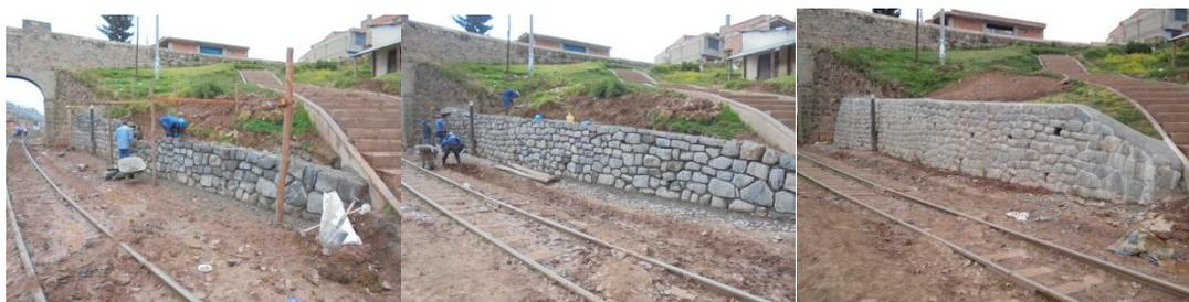
Vista 4, 5, 6.- Muro de contención N° 2 con concreto ciclópeo y piedra de 8", altura de 2.30 m, y longitud de 15m soporte del talud N° 2.
