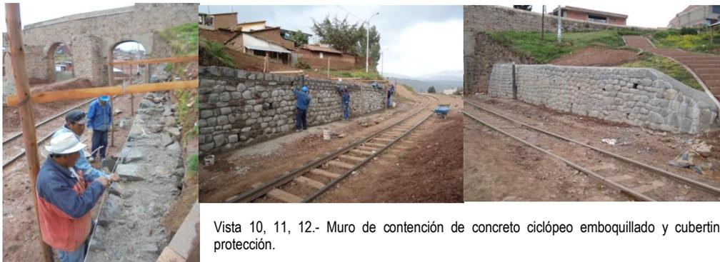
Vista 10, 11, 12.- Muro de contención de concreto ciclópeo emboquillado y cubertina de protección.
