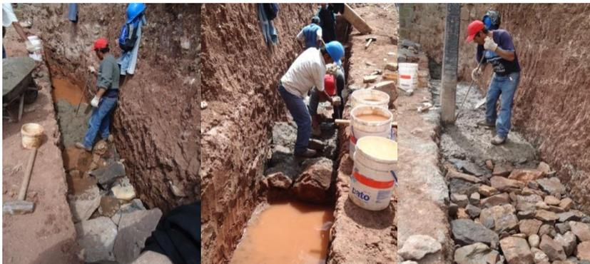
Vista 13, 14, 15.- Vaciado de mezcla de concreto ciclópeo y piedra grande como base para el armado de muro de contención.
