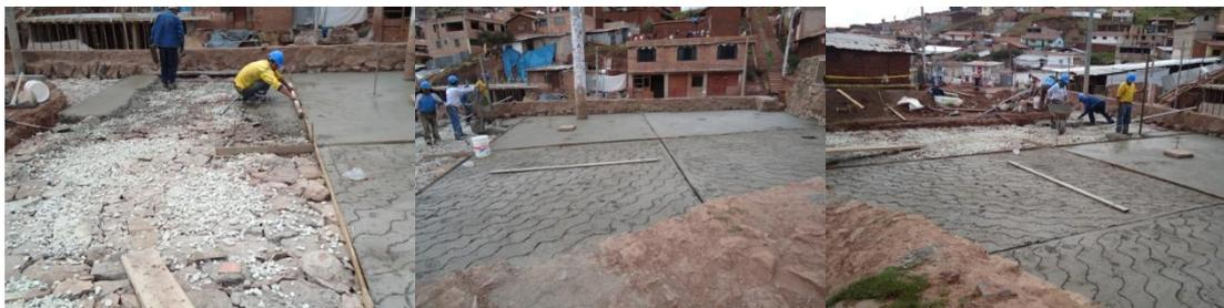
Vista 19, 20, 21.- Vaciado de mezcla de concreto para falso piso de concreto y nivelación según pendiente en las áreas de veredas y Estar IV.
