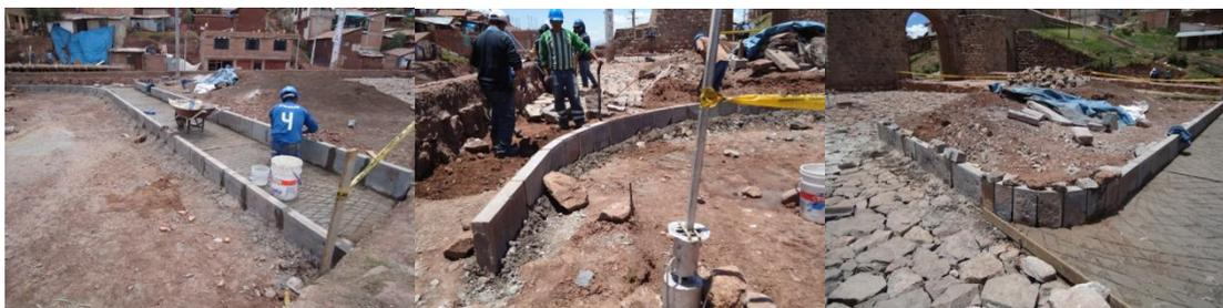
Vista 22, 23, 24.- Colocación de sardinel de piedra asentado con mezcla de concreto, en veredas y en los límites de la jardinera en el Estar IV.
