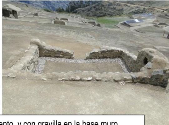
Tratamiento de piso, con cal. Arena, cemento, y con gravilla en la base muro.
