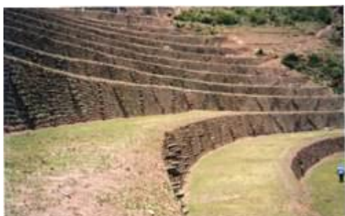
Andenes en el sector de Qosqa, nótese las gradas voladizas (sarunas) en forma geométrica
