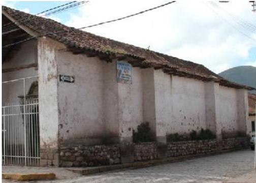
Hacia la base entre contrafuertes un murete de piedra a manera de jardín y un alero con canes de madera labrada.
