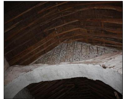
La cubierta del presbiterio es continua a la nave, cuya estructura es de par y nudillo, inclusión de carrizo, barro y tejas, no cuenta con revestimiento ni cielorraso dejando visto la estructura.
