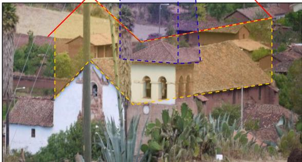
Presenta una sola estructura siendo la diferencia de nivel cero entre la nave y el presbiterio los faldones de cubierta tienen continuidad entre todo el conjunto, a diferencia de los espacios adosados los cuales se hallan a un nivel inferior y en forma transversal a la estructura central.
