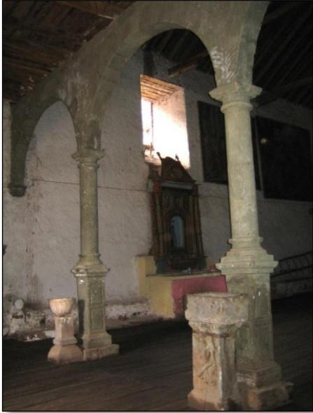
Espacio preámbulo a la nave, enmarcadas por el acceso principal, muro de la epístola y muro del evangelio y las arquerías de medio punto en piedra que soportan al coro, con base de sección cuadrangular y fuste liso con capiteles de factura simple, actualmente recubierto con cemento, provocando la degradación del elemento lítico.
