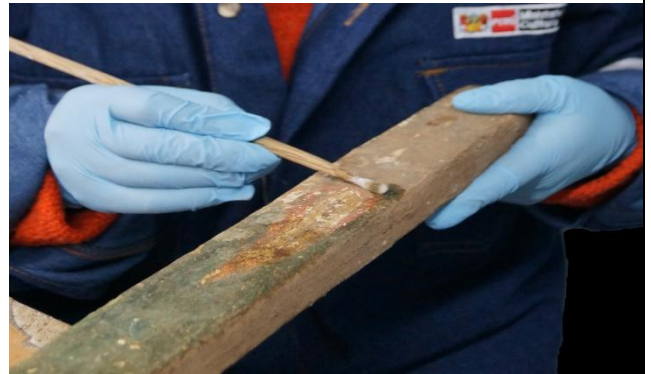
Consolidación estructural (restitución de la madera maguey).
