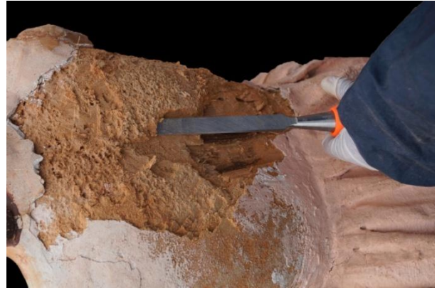
Consolidación estructural (restitución de la madera maguey).
