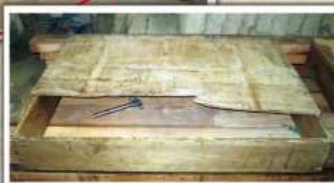
DETALLE DE UNO DE LOS CAJONES, DONDE APLICAMOS EL MAL ESTADO DE CONSERVACION DE LA ESTRUCTURA Y PRINCIPALMENTE DE LA BASE
