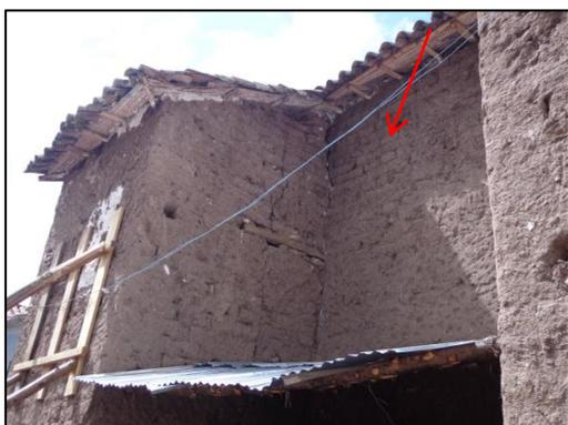
Aparentemente los contrafuertes fueron contruidos bien ya que se notan externamente; pero al momento de realizar la calzadura de los muros es los contrafuertes se demuestra que fueron contruidos de una muy mala forma ya que se presenta en el interior a manera de un relleno de material lítico y barro, producto de estos malas construcciones los muros presentan fisuras los cuales han sido intervenidas durante los trabajos para evitar que estos colapsen.
