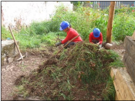
Eliminación de material excedente en el Atrio principal
