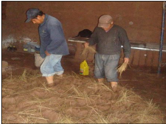
Preparación de mortero en general para el tratamiento de piso y paredes del Gabinete
