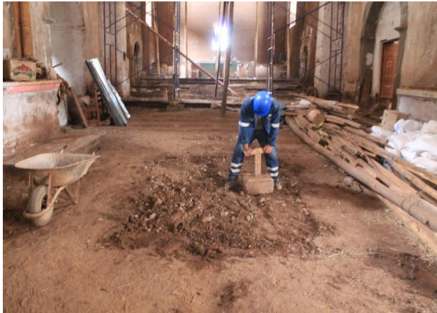
Nivelación y apisonado de la T-09 ubicado en la Nave central.
