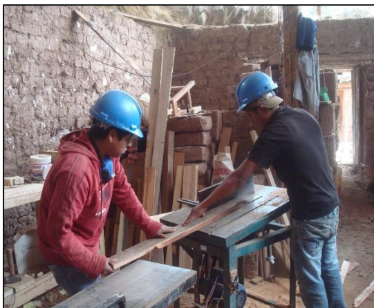
Construcción de muebles (mesas, bancos, andamios) para el Gabinete
