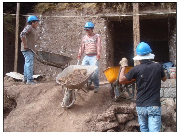
Eliminación de material de relleno de unidades de excavación
