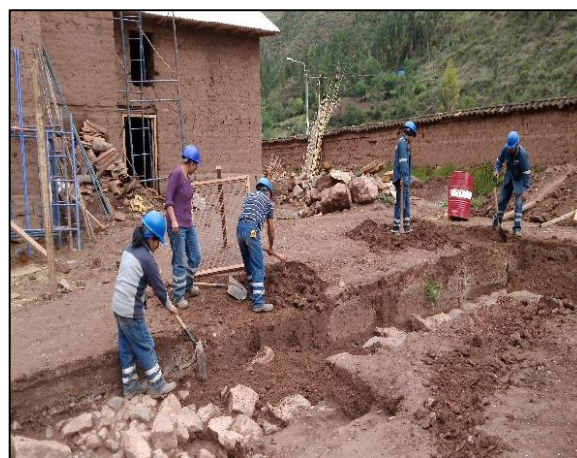
Relleno con material propio en el atrio posterior
