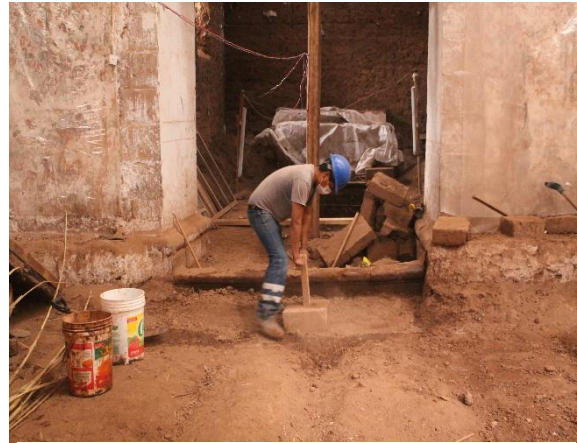
Nivelación y apisonado de la UE-01 Nave central.
