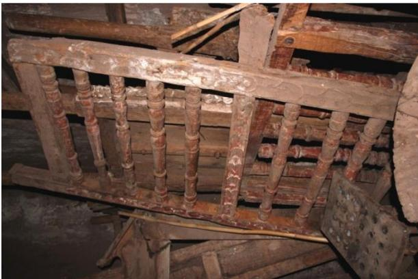
Este espacio que delimita el área del presbiterio de la nave está definido por un desnivel de 0.50m y la adición de una grada de piedra en la parte central, cuya configuración inicial abarcaba todo el ancho del templo; asimismo se verifica la existencia de una balaustrada actualmente retirada y almacenada durante el cambio de piso actual de ladrillo pastelero.
