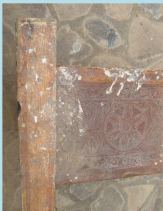
Chorreras de pintura y barniz oxidado
