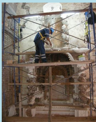
Empastado y entizado de columnas, capiteles y pilastras
