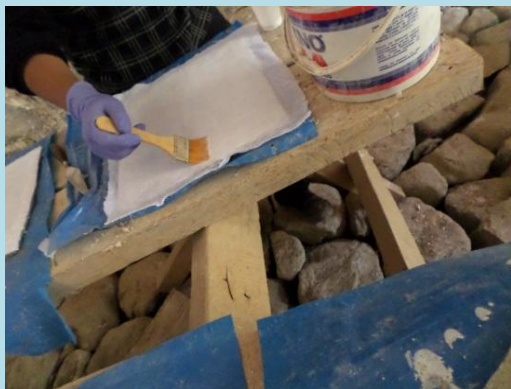
Adhesión de gasa primer soporte nuevo
