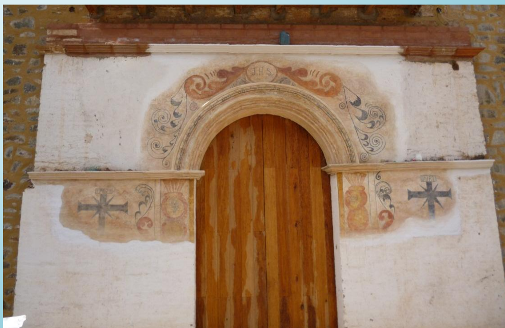
Registro fotográfico final
