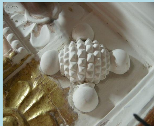
Entizado, lijado y restitución de molduras faltantes
