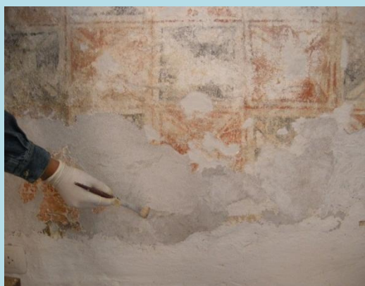
Restitución de repellado y encalados
