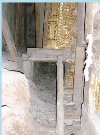
Inestabilidad estructural zona posterior banco apuntalado
