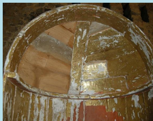
Restitución de tableros estructurales en cornisa y hornacina
