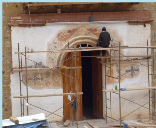
Reintegración cromática (técnica veladura y rigattino)
