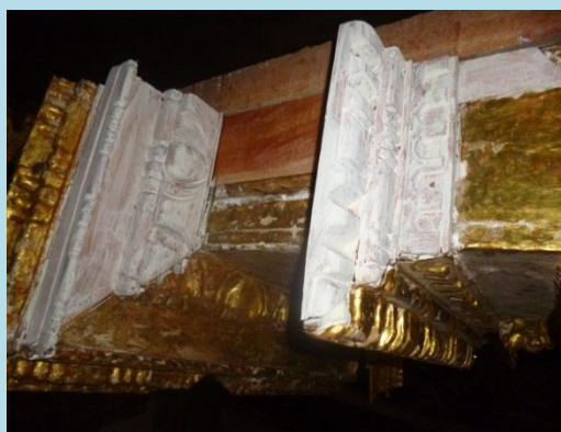
Masillado y entizado de tallas restituidas
