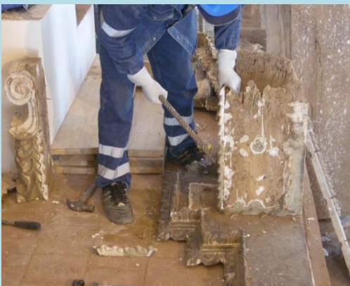
Consolidación estructural (restitución de tableros)
