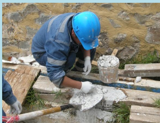
Hidratación y tamizado de cal
