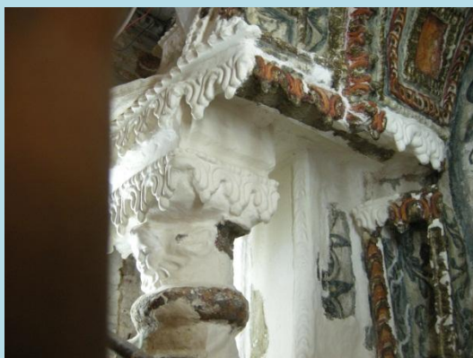
Empastado y entizado de molduras restituídas
