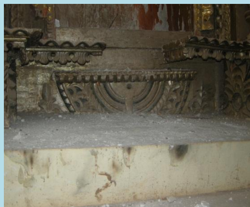
Presencia de concreto cubriendo el banco
