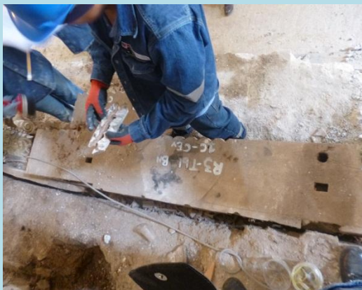
Desmontaje y codificación de piezas de retablo
