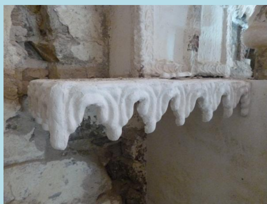
Restitución de molduras y empastados de bases de preparación pérdidas
