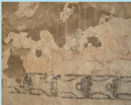
Presencia de pintura mural
