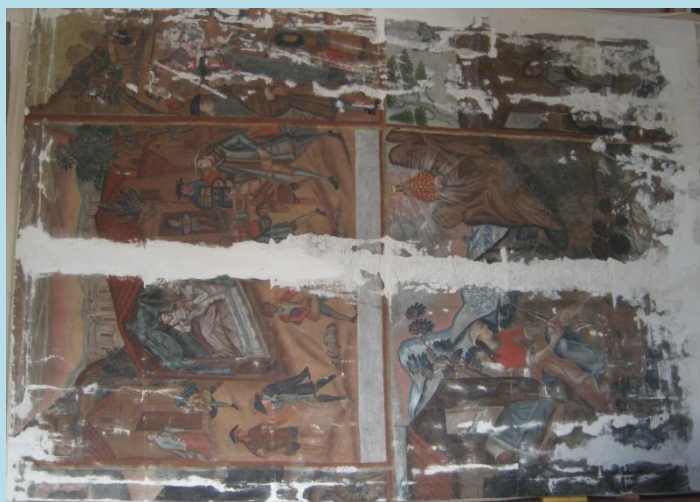
Registro fotográfico final
