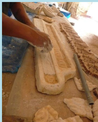
Elaboración de copias, para la restitución de molduras
