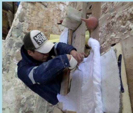
Adhesión de gasa primer soporte nuevo
