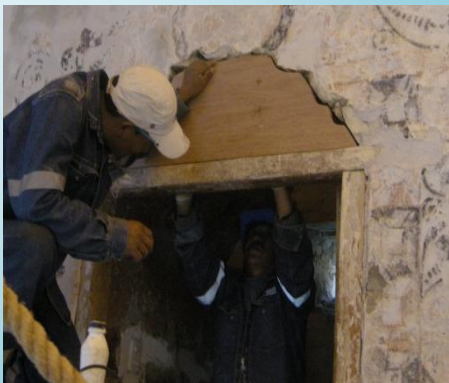
Restitución de tablero
