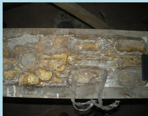
Perdidas de bases de preparación
