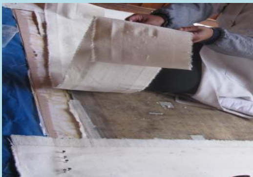
Colocación de bandas
