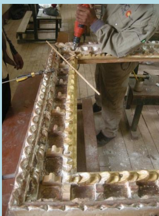
Consolidación estructural de cornisas y marcos
