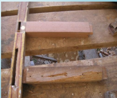
Restitución de elementos estructurales
