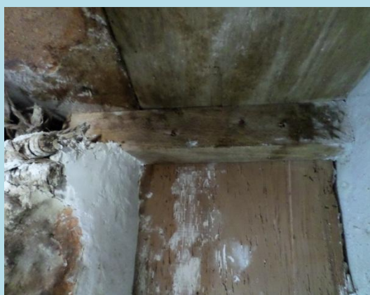
Deterioro estructural por ataque de xilófagos (tableros laterales de pilastras y yugos)
