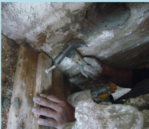
Reforzamiento estructural con barrotes
