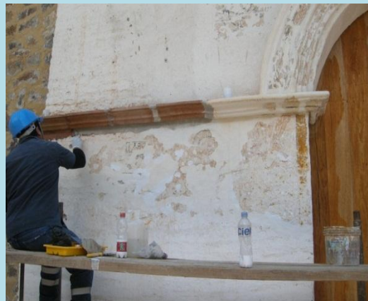
Restitución de repellados
