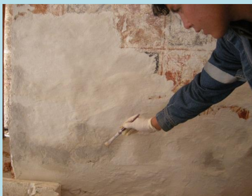
Restitución de encalado y enlucido
