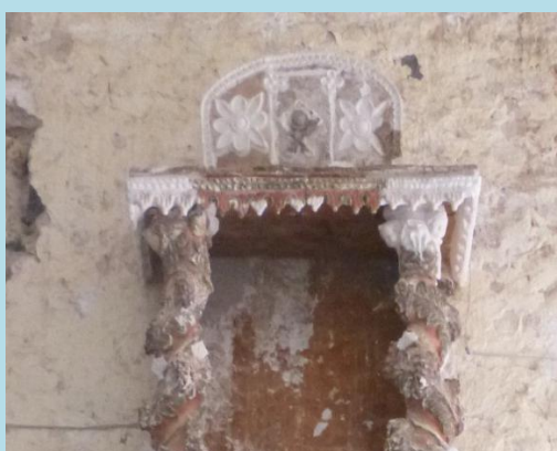
Restitución de molduras y empastados de bases de preparación pérdidas
