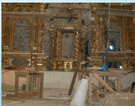
Banco de carpintería, mesa para sierra circular y mesa para trabajos en piezas de retablo
