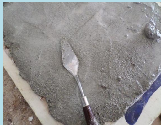
Repellado y nivelado de lagunas
