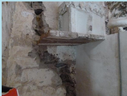
Consolidación estructural de cornisa
