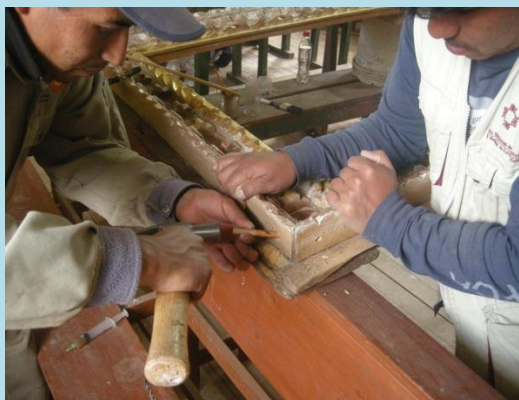
Consolidación de juntas y ensambles desfasados en cornisas y marco del segundo cuerpo
