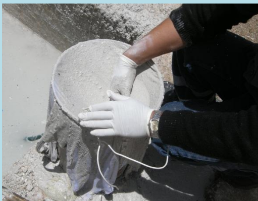
Hidratación y tamizado de cal
