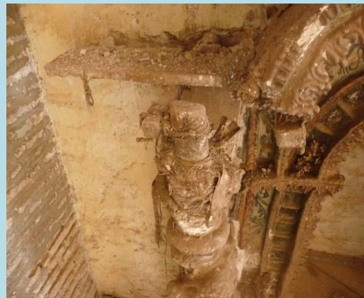
Inestabilidad estructural en columnas y cornisas
