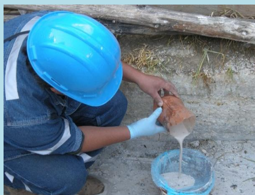
Tamizado e hidratación de cal
