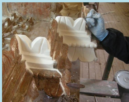
Entizado y lijado de molduras talladas restituidas (entablamento)
