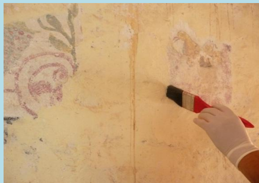
Realización de calas de exploración
