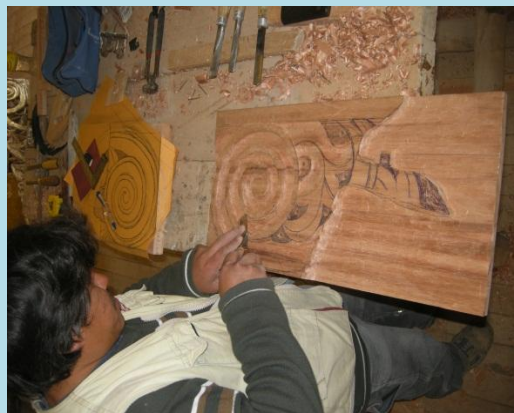
Restitución de tableros y molduras talladas
