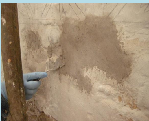
Restitución de repellados y encalados
