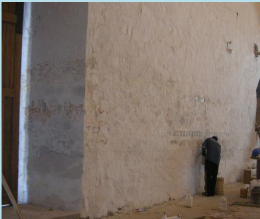
Restitución de encalado y enlucido
