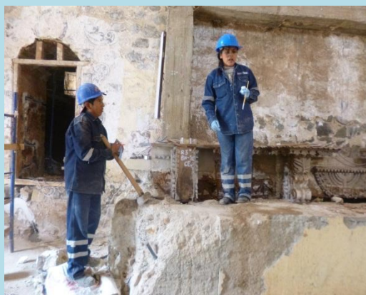
Desmontaje y codificación de piezas de retablo
