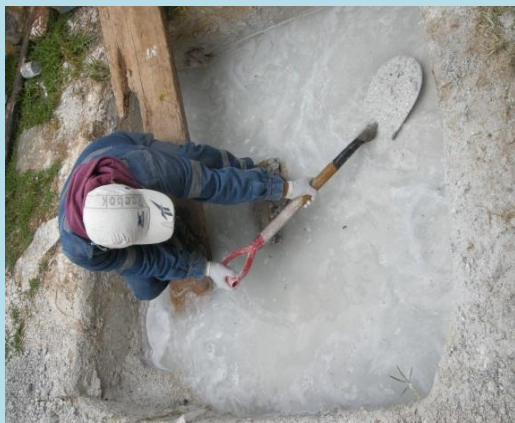
Hidratación y tamizado de cal
