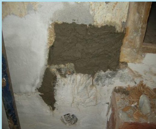
Restitución de repellado
