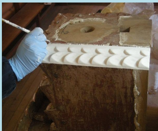
Entizado de molduras talladas restituidas (entablamentos)
