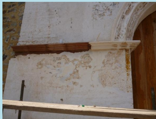
Perdida de bases de preparación
