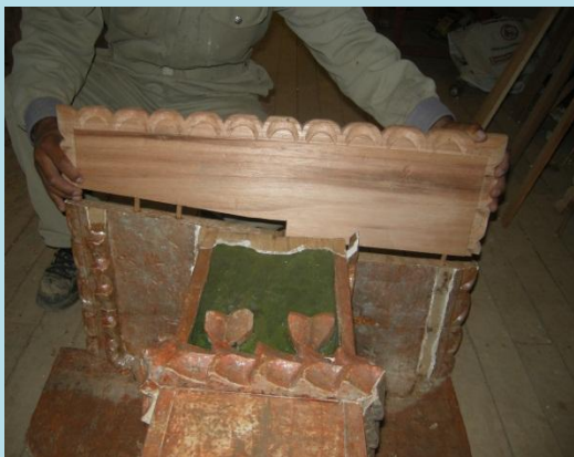
Restitución de tableros y molduras talladas
