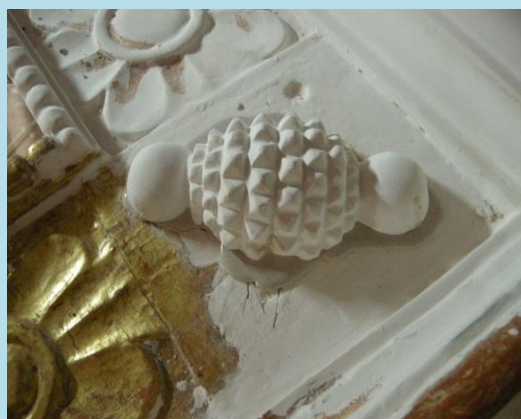
Empastado, entizado, lijado y restitución de molduras talladas
