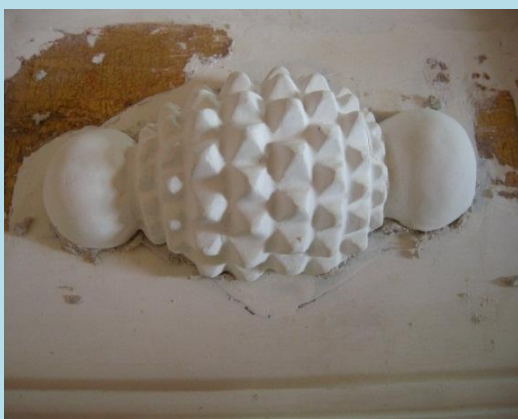
Empastado, entizado, lijado y restitución de molduras talladas
