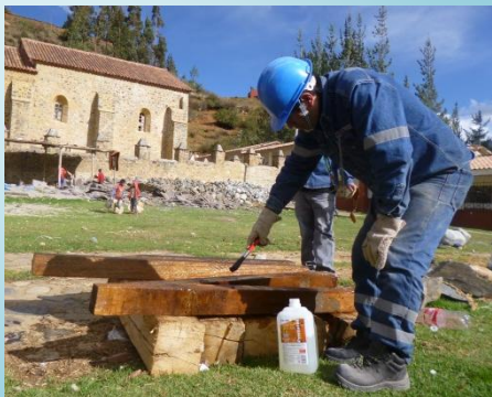
Saturación y protección de yugos
