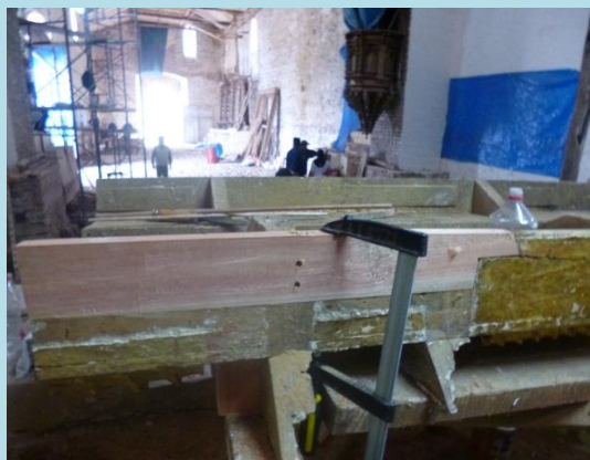
Consolidación estructural (restitución de tableros)
