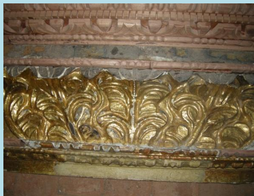
Eliminación de barniz oxidado y limpieza del pan de oro
