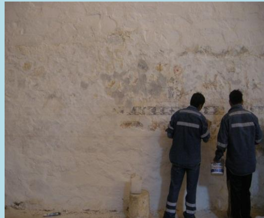
Restitución de encalado y enlucido
