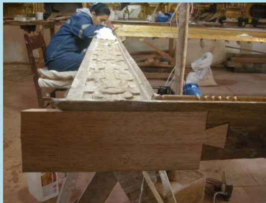
Restitución de soporte estructural
