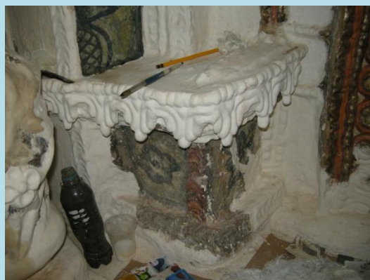
Empastado y entizado de molduras restituídas
