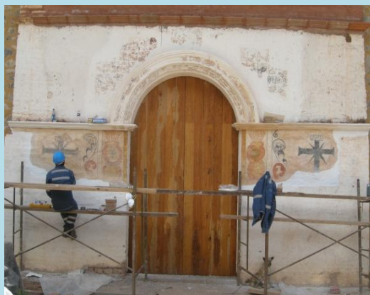
Reintegración Cromática (técnica veladura)
