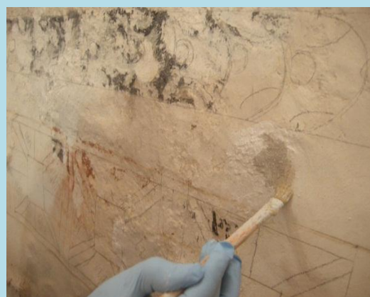
Restitución de repellados y encalados
