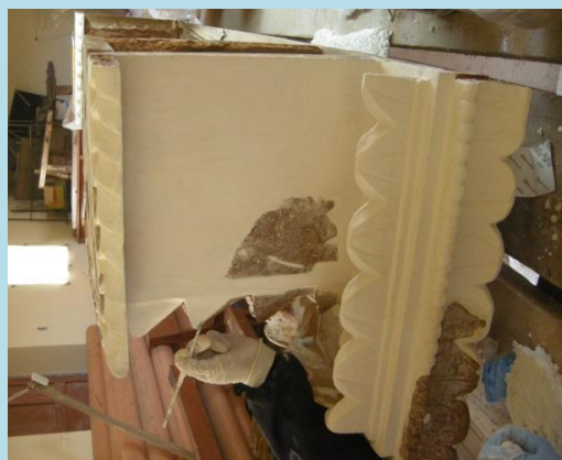
Entizado de molduras talladas restituidas (entablamentos)
