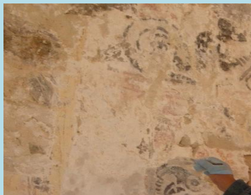
Liberación de recubrimientos
