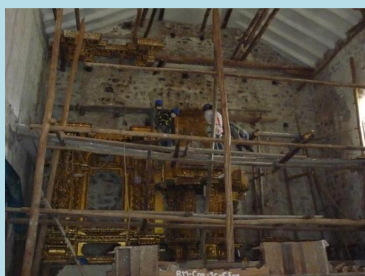
Codificación y desmontaje de retablo por piezas
