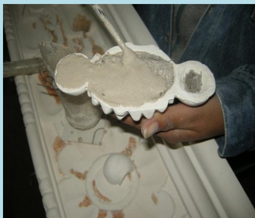
Entizado, lijado y restitución de molduras faltantes
