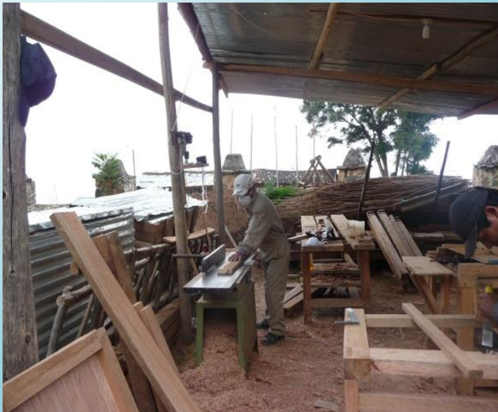
Habilitación de madera para la realización de mesas de trabajo
