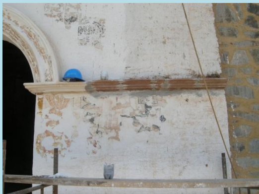
Perdida de bases de preparación
