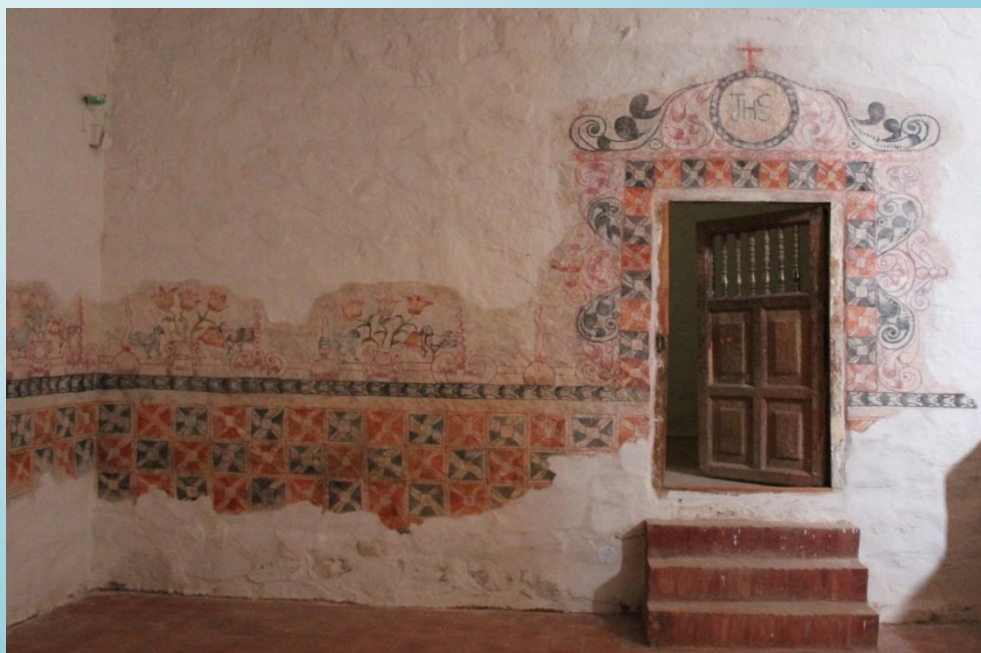
Registro fotográfico final
