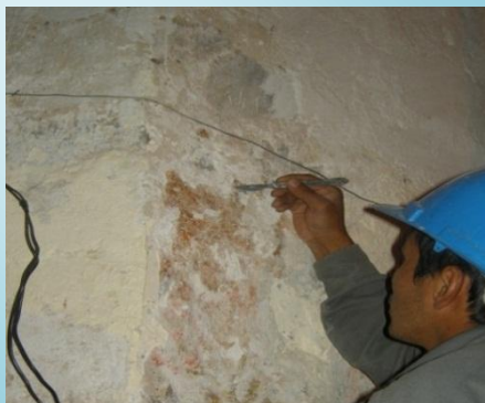
Liberación de recubrimientos
