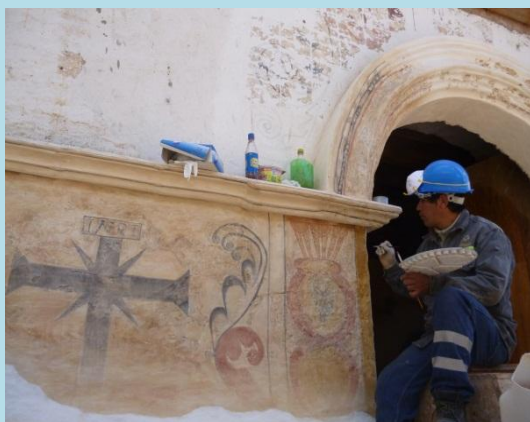
Reintegración cromática (técnica veladura y rigattino)
