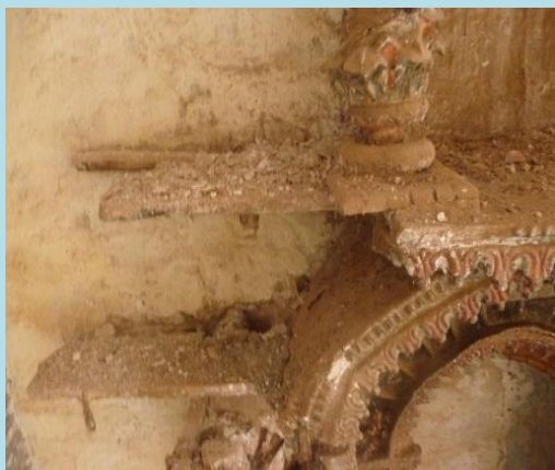
Desmonte presente en cornisas fracturadas
