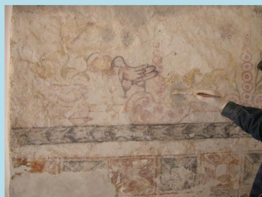
Restitución de encalado y enlucido
