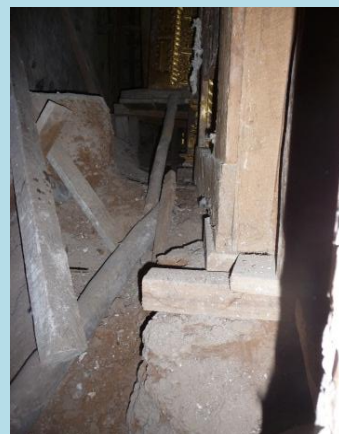
Inestabilidad estructural zona posterior banco apuntalado
