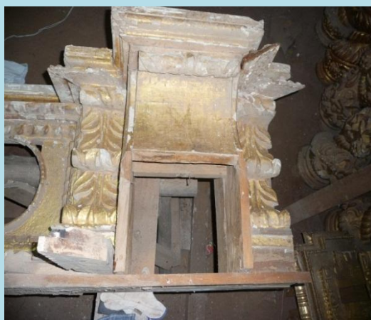
Pérdidas estructurales talladas
