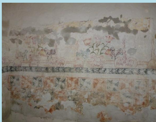
Restitución de repellado y encalados
