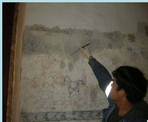
Restitución de repellado y encalado
