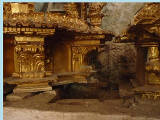
Desfase del banco calle central y lateral
