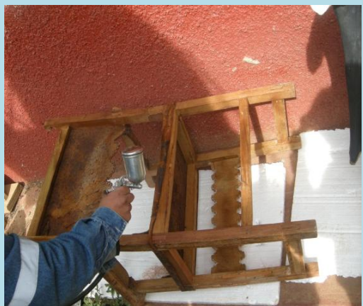
Barnizado de protección final
