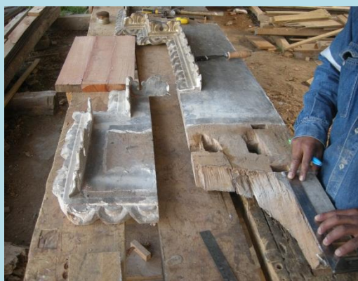
Restitución de tableros estructurales en cornisa y hornacina
