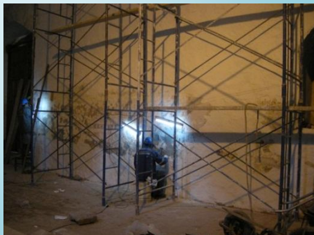
Liberación de recubrimientos
