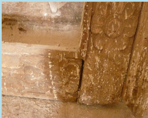
Separación de juntas y ensambles
