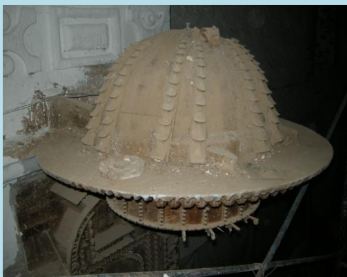
Acumulación de polvo, tierra y desmonte
