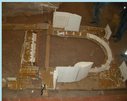
Masillado y entizado de tallas restituidas
