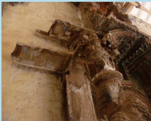
Inestabilidad estructural
