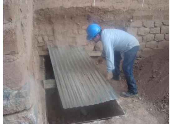
cobertura de las unidades intervenidas con calaminas para evitar el empozamiento por las aguas pluviales.
