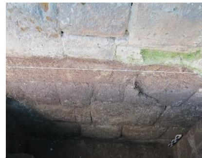
Foto N° 02, Vista del Detalle del Almohadillado y la Junta Seca del Muro Evidenciado en la Excavación Arqueológica
