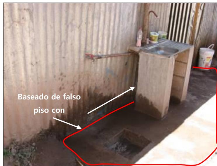
Para evitar un foco infeccioso por aguas residuales se instala un falso piso de cemento conectando a un desagüe controlando de esta manera la proliferación de patógenos, así mismo se reinstala el lavatorio asegurando la higiene personal y laboral
