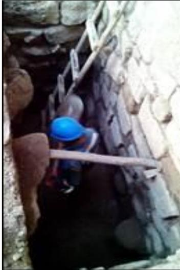
Se constata que en las excavaciones se están apuntalando los muros para evitar deslizamientos
