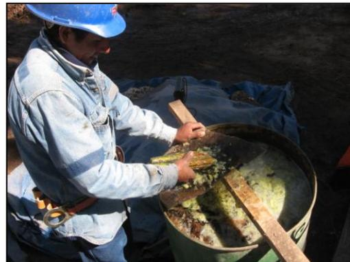
Tratamiento del gigantón que es rayado y mezclado con agua para después ser nuevamente mezclado con la tierra cernida, la que será usada en el embarre de estructuras del Templo.
