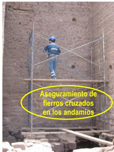
Véase la instalación de los andamios en la que se refuerza la seguridad e instalación adecuada
