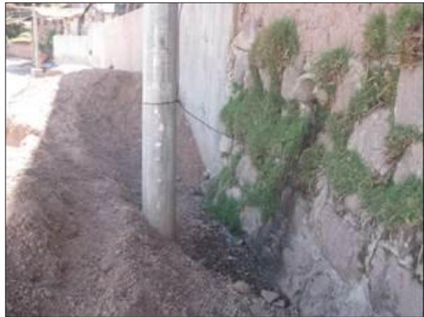
Agua residual del comedor entubada para desfogue a la calle causando contaminación, impacto visual y daño a las estructura
