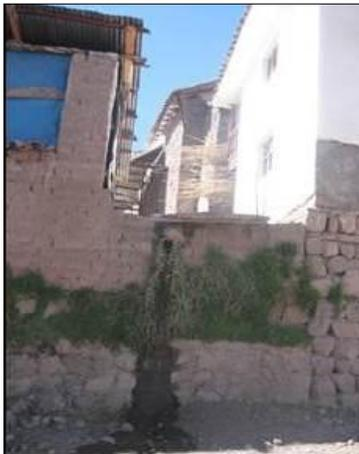
Agua residual del lavatorio que puede causar contaminación y daña la estructura de la construcción
