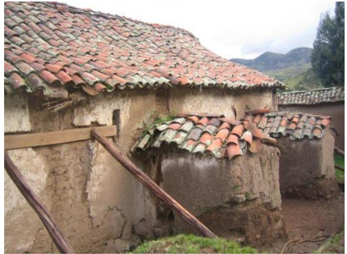
el evangelio se verifica la existencia de dos contrafuertes de adobe de diferente dimensiones, ambos se encuentran en muy mal estado de conservación, los cimientos y sobrecimientos se encontraban soterrados por desmonte y la presencia de pastos los que después de la obras de emergencia quedaron totalmente expuestos y húmedos, presenta capilaridad de la humedad hacia los muros.
