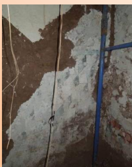
REPELLADO DE LAGUNAS
