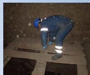
DESMONTAJE POR PIEZAS
