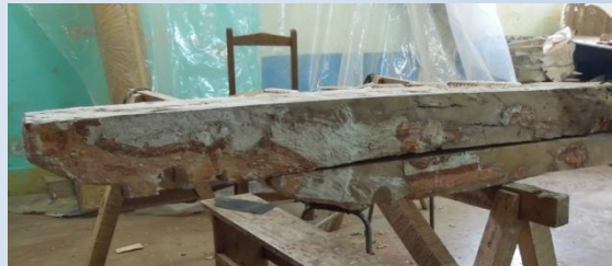
CONSOLIDACIÓN ESTRUCTURAL DE MENSULAS
