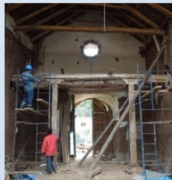
CONSOLIDACIÓN ESTRUCTURAL, NIVELACIÓN Y CONSOLIDACIÓN DE ANCLAJES A LOS MURO EN GENERAL
