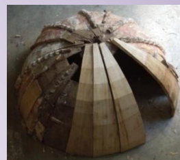
RESTITUCION DE PIEZAS FALTANTES
