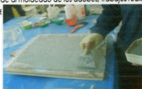
Fotog. 052 y 053 : Se continuaron labores de repellado y nivelación en fragmentos anteriormente desmontados.
