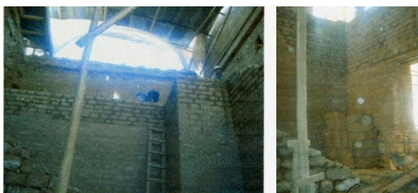
Fotog. 029 y 030 : Vistas de labores de restitución de muros de adobe, que cierran el ambiente de deposito de andas en sus muros Sur, Oste y Norte.
