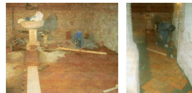
Fotog. 036 – 038 : Vistas del proceso de restitución de pisos de Ladrillo pastelero en ambiente del Baptisterio, se inicia con una línea central a partir del acceso.
