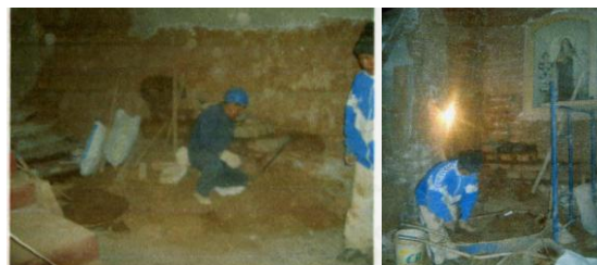
Fotog. 026 - 028 : Vistas de sectores en los que se efectuaron labores de calzadura y consolidación de muros de adobe; interior del presbiterio y muro Norte interior de la Capilla de las Animas.
