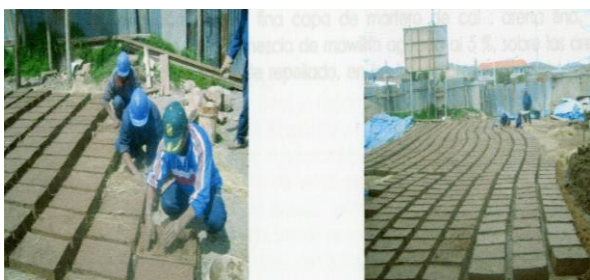
Fotog. 047 y 048 : Al cuarto día se procede al moldeado de los adobes; trabajos realizados en los atrios principal y latr
