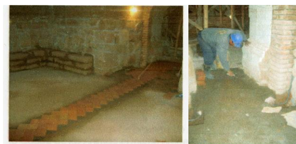
Fotog. 036 – 038 : Vistas del proceso de restitución de pisos de Ladrillo pastelero en ambiente del Baptisterio, se inicia con una línea central a partir del acceso.
