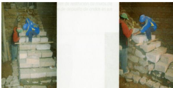
Fotog. 024 y 025 : Proceso de reposición de escaleras de acceso al Coro Alto, con piezas líticas nuevas, asentadas sobre mezcla de concreto.
