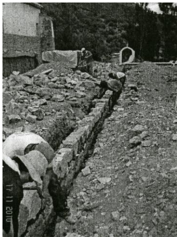
Trabajos ejecutados en la barda perimetral, cimientos y sobrecimientos
