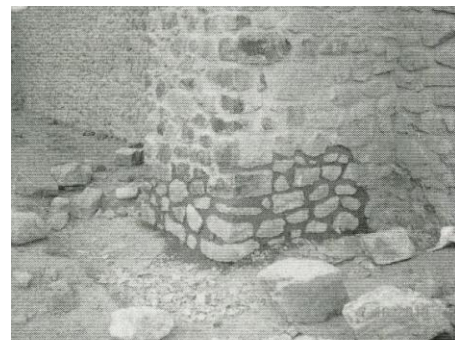
CALZADURA EN CONTRAFUERTE
