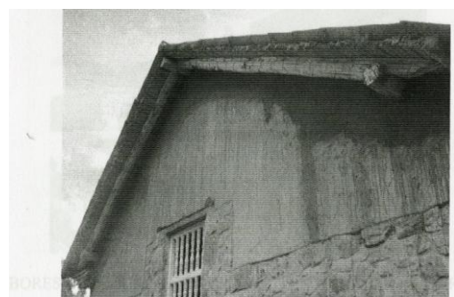
EMBARRE EN MURO EXTERIOR DE CAPILLA SACRISTIA
