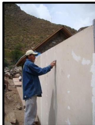
Armado de Estructuras metálicas, colocado de muros Superboard y relleno con espuma de
