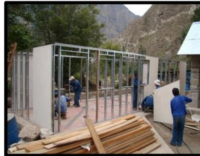
Entornillado y macillado de muros Drywall
