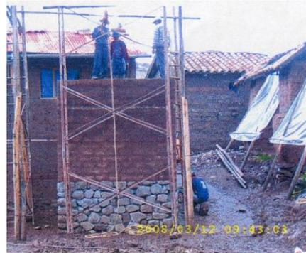
Se muestra labores de asentado de muros de 0.60m de ancho de adobes en la torre exenta.
