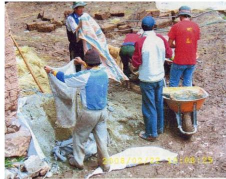
Vista en la que se muestra el traslado manual (en huanto) de hormigón desde una distancia de 600 m por los peones.
