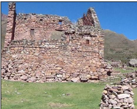
Estructura rectangular en mampostería simple de piedras canteadas unidos con mortero de barro, se puede apreciar el enlucido interior (embarre) con mortero de barro mezclado con paja, Una de las peculiaridades del recinto es que consta de dos niveles, la tipología de vanos abiertos y cerrados.
