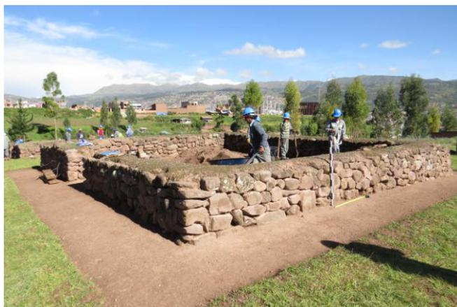
FOTOS 105 AL 110. EN LAS VISTAS SE OBSERVA EL TRABAJO Y VERIFICACION DEL RETIRO DEL MORTERO INSERVIBLE PARA LA POSTERIOR COLOCACION DE UN MORTERO NUEVO.
