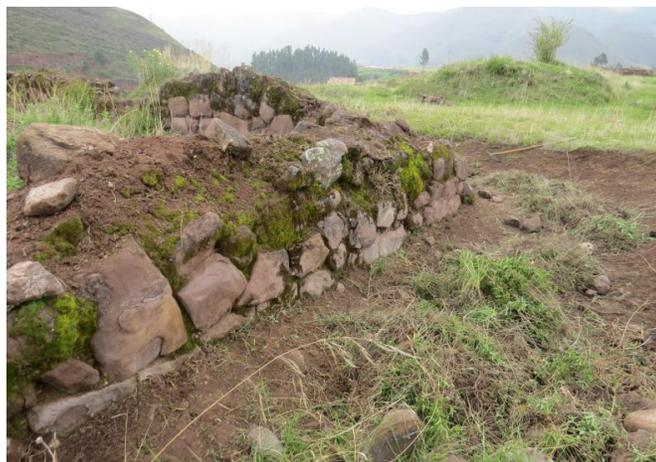
FOTOS 32 AL 37 SE OBSERVA LOS TRABAJOS DE ELIMINACIÓN DE MALEZA EN PARAMENTOS, SE HALLO GRAN CANTIDAD DE ESPINAS, PARA LA EXTRACCIÓN DE LA FLORA NEGATIVA SE UTILIZO SIERRAS, ALICATES.
