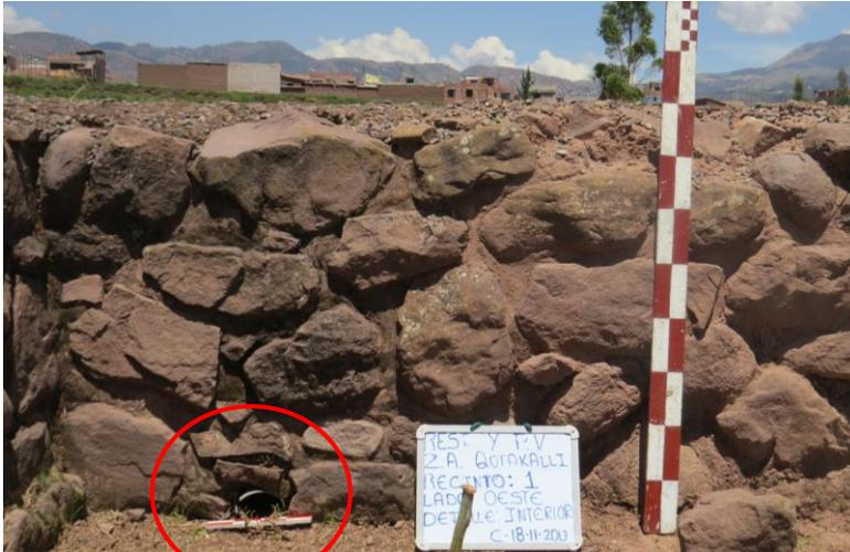
Tubos de PVC, colocados en una intervención anterior, las mismas que evacuan el agua de las lluvias hacia el interior de las estructuras, ocasionando humedad
