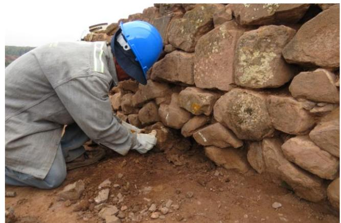
**FOTOS 88 AL 93. EN LAS FOTOS SE OBSERVA LOS TRABAJOS DE CALZADURA EJECUTADOS EN LOS RECINTOS CON LA FINALIDAD DE DARLE MAYOR ESTABILIDAD A LOS PARAMENTOS.**
