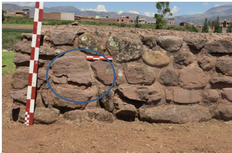
**MUCHOS DE LOS MAMPUESTOS DE LOS RECINTOS 01 Y 02 SE ENCUENTRAN CON FISURAS Y GRIETAS, SIENDO NECESARIO EL CAMBIO DE ESTAS POR ELEMENTOS LITICOS NUEVOS. ADEMAS SE OBSERVA QUE EL MORTERO SE HA DEGRADADO EN FORMA Y POR ENDE YA NO CUMPLE SU FUNCION DE ELEMENTO COHESIONADOR ENTRE LOS ELEMENTOS LITICOS.**
