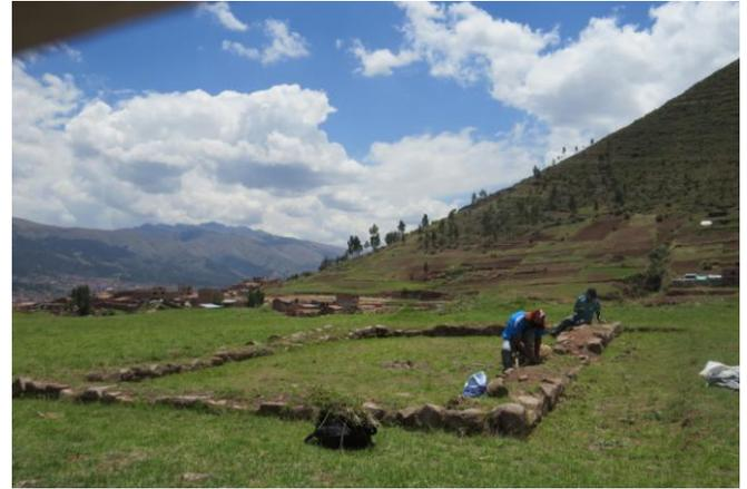
**FOTOS 38 Y 39: SE OBSERVA EL TRABAJO MINUCIOSO EJECUTADO EN LOS RECINTOS INTERVENIDOS ANTERIORMENTE. ESTA LABOR ES MUY NECESARIO DEBIDO A QUE LAS RAICES DE LA FAUNA QUE CRECE SOBRE LOS PARAMENTOS DESESTABILIZA EL NUCLEO DEL PARAMENTO.**
