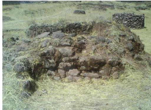
Pérdida de mortero original entre las juntas de los elementos líticos debido a la aparición de fisuras por donde fácilmente filtran las aguas pluviales hacia el núcleo del paramento degradando el material.
