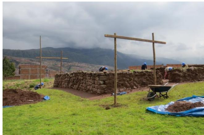
**FOTOS 40 - 41: EN LAS FOTOS SE OBSERVA EL TRABAJO LA COLOCACION DE LAS BALIZAS Y CRUCETAS PARA LOS TRABAJOS DE RESTAURACIÓN DEL RECINTO 02.**
