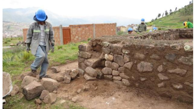
**FOTOS 99 – 100. SE OBSERVA EL DESARMADO DE MURO EJECUTADO EN FORMA MANUAL.**
