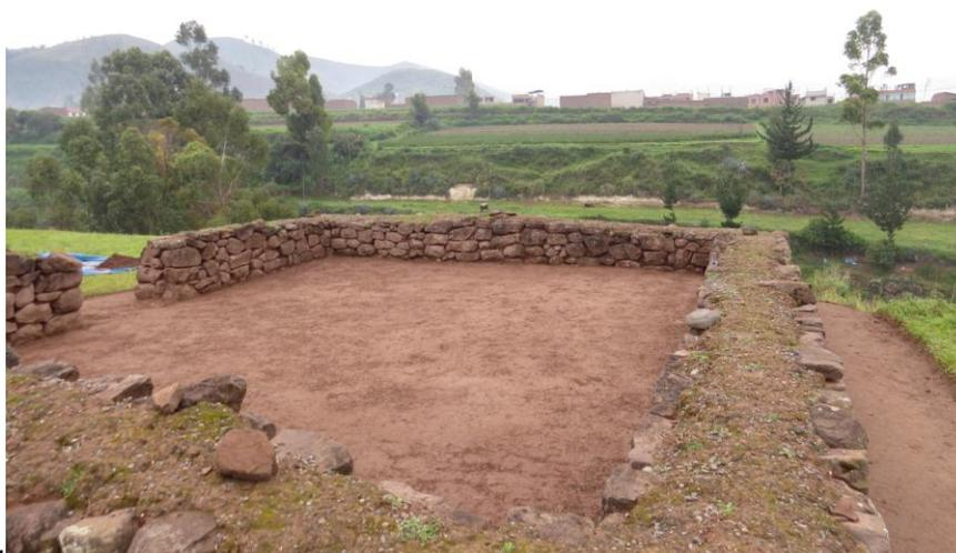
FOTOS 135 AL 139. SE OBSERVA EL RETIRO DE LAS RAICILLAS, EL POSTERIOR APISONADO CON UN MORTERO DE MEJOR CALIDAD COMO PARTE DEL TRATAMIENTO DE PISOS EJECUTADOS EN LOS RECINTOS.
