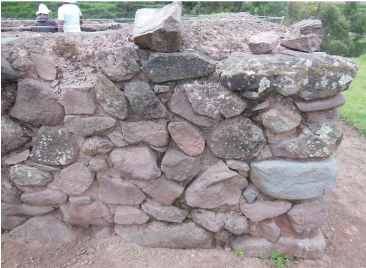
Las estructuras intervenidas anteriormente, se encuentran en proceso de deterioro debido a la inadecuada intervención y uso de materiales irreversibles los que han ocasionado mayor daño a los elementos constituyentes de las diferentes estructuras.
