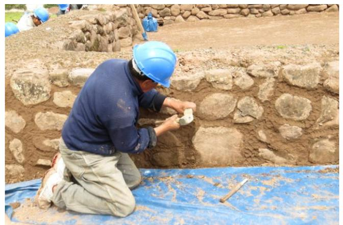
FOTOS 111 AL 116. SE OBSERVA LA COLOCACION DE UN NUEVO MORTERO Y EL TRATAMIENTO CON COBAS DE MADERA PARA APRISIONAR EL NUEVO MORTERO ENTRE LAS JUNTAS DE LOS ELEMENTOS LITICOS DE LOS PARAMENTOS.
