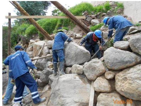
**EMBOQUILLADO CON MORTERO DE TIERRA, ARCILLA, CEMENTO (REALIZADO EN 03 ETAPAS)**
