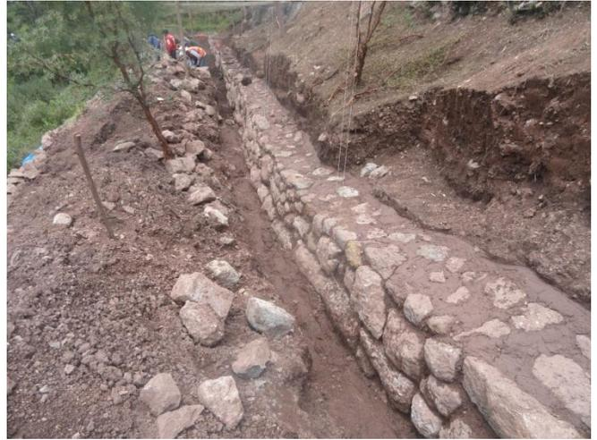
RELLENO CON MATERIAL PROPIO EN LA BASE DEL MURO DEL ANDEN 2B Y NIVELACION Y APISONADO DEL MISMO SECTOR
