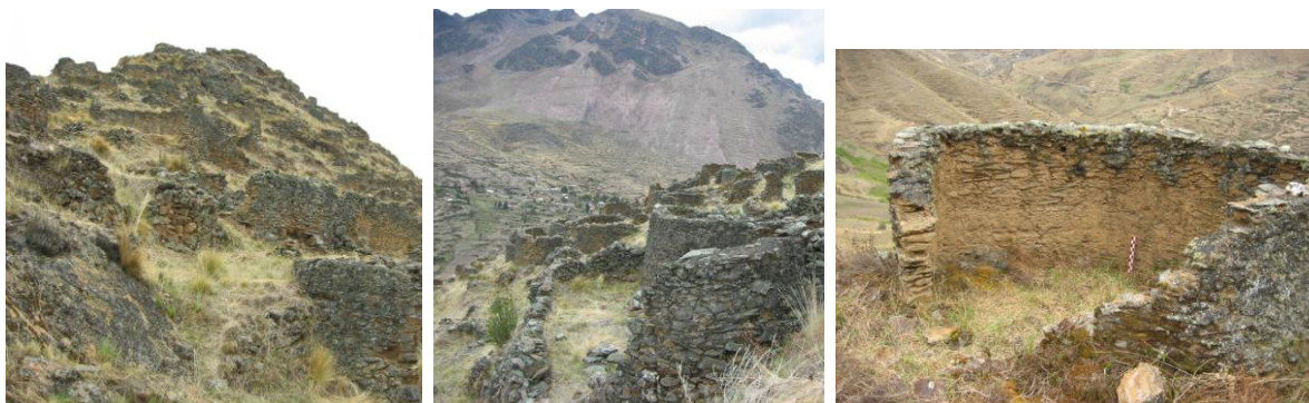
LAS EDIFICACIONES NO CUENTAN CON UN PATRON URBANISTICO, SON CIRCULARES, EN BASE A MAMPUESTOS DE LAJAS DE ESQUISTO PIZARROSO, UNIDAS CON MORTERO DE BARRO; LOS MUROS MUESTRAN EVIDENCIA DE REVESTIMIENTO
