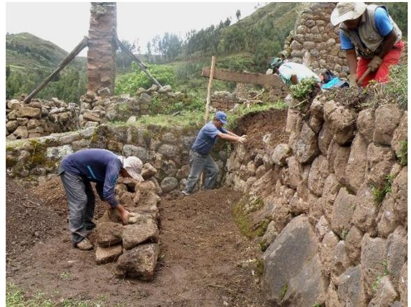
Vistas en las cuales se detalla la ejecución del proceso de desmontado del muro a ser intervenido con trabajos de recomposición, la misma que se hizo con el empleo de herramientas manuales.
