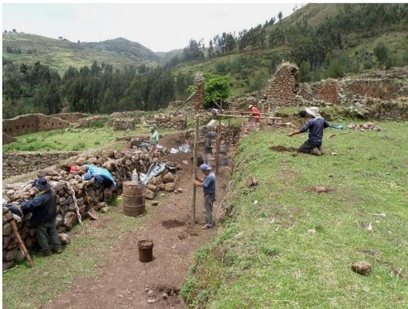
En las vistas se aprecia al personal en proceso de armado de las balizas y crucetas, para ejecutar los trabajos de recomposición y restitución.
