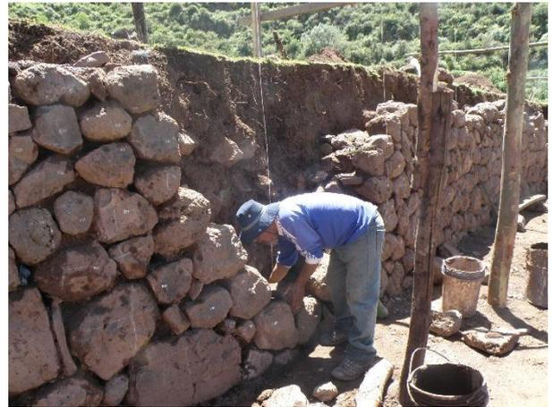
Vista superior izquierdo en la cual se detalla el tramo colapsado, mientras que en la vista superior derecho se aprecia al personal en proceso de restitución del tramo colapso con material propio, ello se hizo con la técnica de anastilosis.
