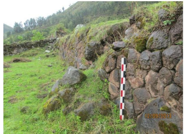
Vistas que fueron tomados después de los trabajos de corte y eliminación de malezas, vista superior izquierda, tramo de muro en la cual se aprecia el faltante de los elementos líticos, vista superior derecho detalla en pandeamiento del muro.
