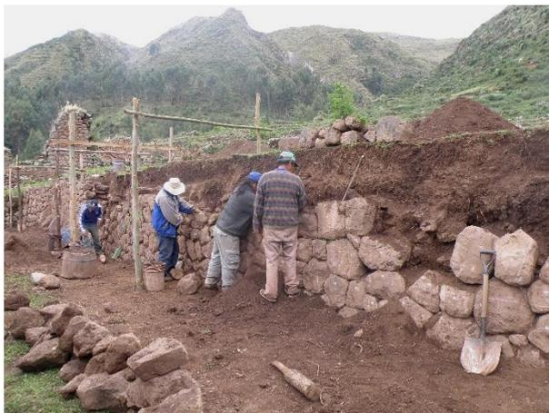
En las vistas se aprecia al personal en proceso de recomposición del muro de andén de aparejo concertado (VII), ello con el empleo de herramientas manuales.
