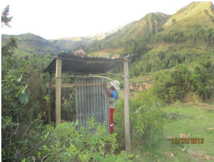
Vista en la cual se aprecia al personal en proceso de construcción (empleo de planchas calamina, clavos y listones)
