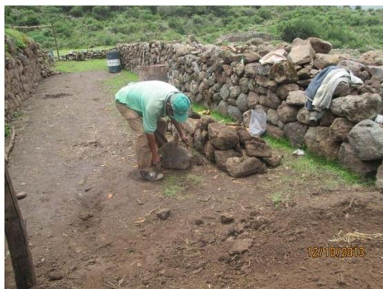
En ambas vistas se observa el proceso de desmontado del paramento de aparejo de anden N° VIII, las mismas que se hizo de manera manual.
