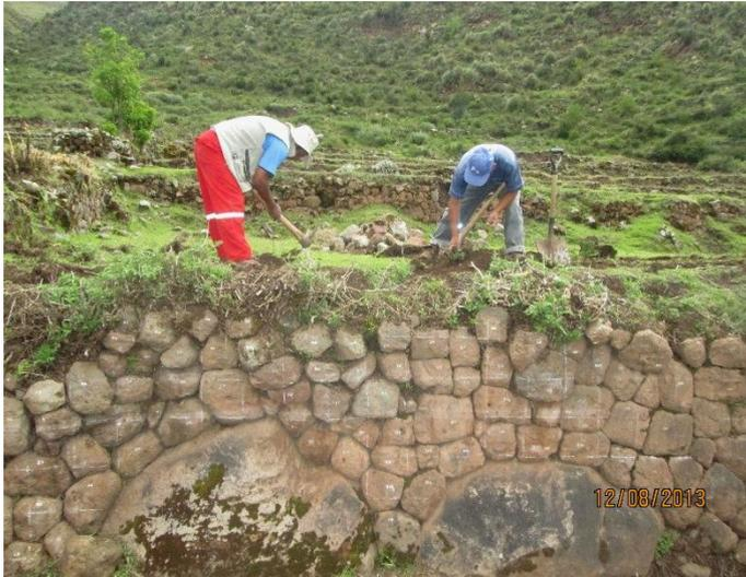
Vistas que detalla al personal en proceso de extracción de raíces en la cabecera del muro del Anden VIII.
