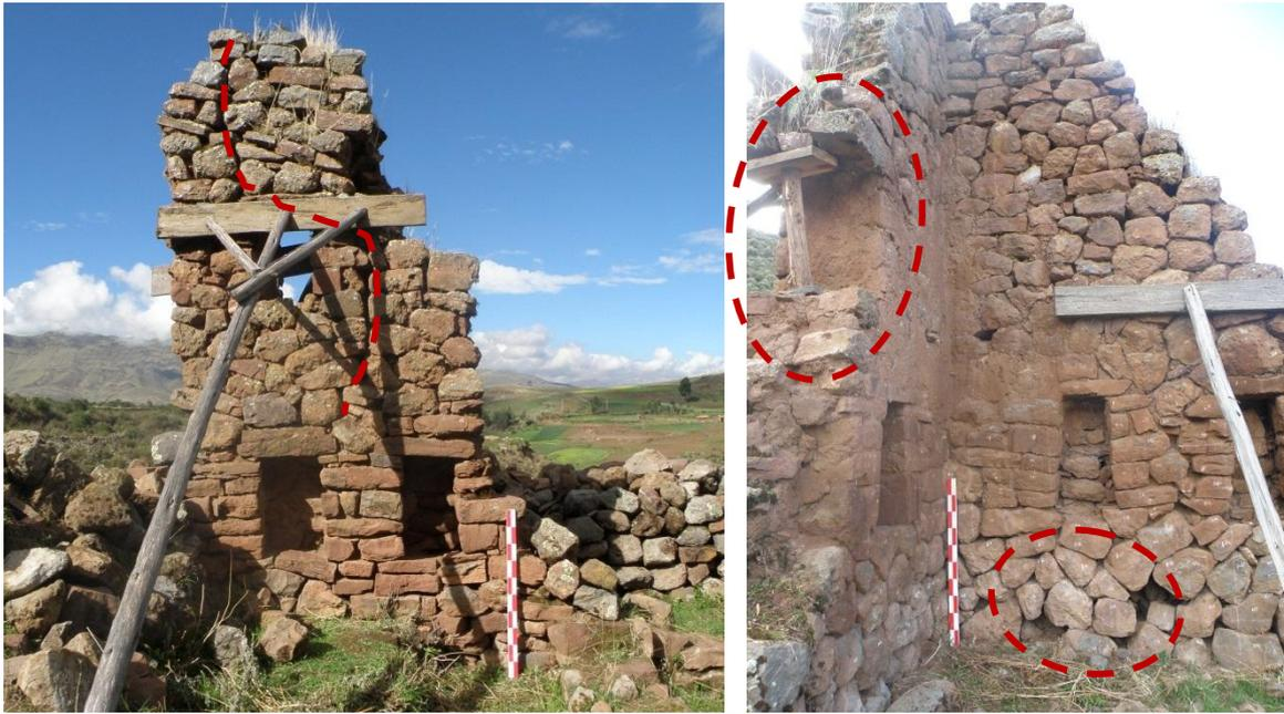
En ambas vistas se observa los paramentos de los muros de recintos de planta rectangular con presencia de grietas, pandeamiento y desprendimiento de elementos líticos, estas que se observan debidamente resaltados con líneas entre cortadas.
