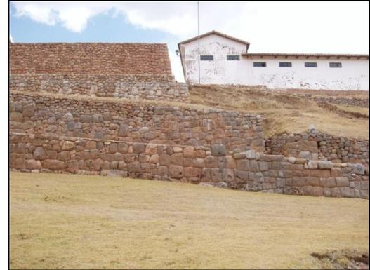
El **andén 4** compuesto por una plataforma que se une a través de una rampa con el andén 5, en ambos casos presentan pérdida de los muros de contención,
