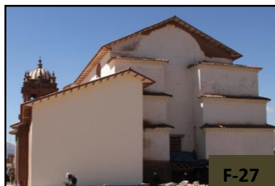
Vista 27.- Embarre en muro exterior sacristia con mortero de tierra, arcilla, paja y pintado final.
