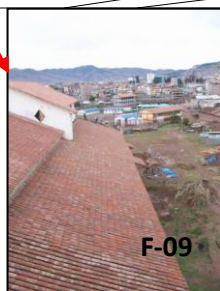
Vista 09.- Cubierta de la Nave de la Epístola concluida con teja de arcilla colonial.
