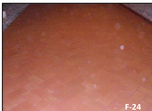
Vista 24.- asentado de piso de ladrillo pastelero en capillas de la Nave del Evangelio.
