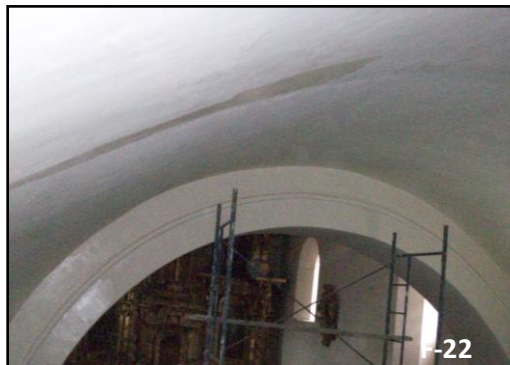
Vista 22.- Encarrizado en bóvedas intradós con qur qur real, carrizo y enlucido con yeso.
