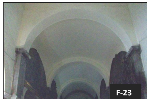
Vista 23.- Interior en bóvedas intradós enlucido con yeso.
