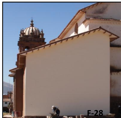
Vista 28.- Embarre y pintado concluido en muro exterior de la Sacristia con mortero de tierra, arcilla y pintura.
