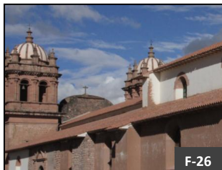
Vista 26.- Cambio de cubierta en la nave central.
