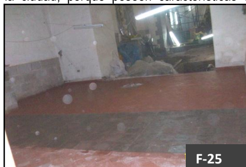
Vista 25.- Piso de lajas de piedra y ladrillo pastelero colocados en las Capillas del Dulce Nombre de Jesus y de la Preciosa Sangre de Jesus.
