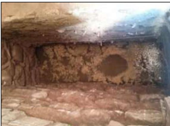
Imagen de filtración de agua a -1.83 m procedente de la crecida de río en temporadas de lluvia.
