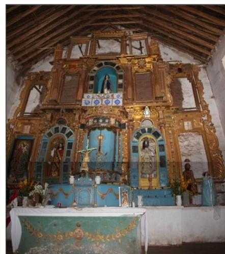
La calle central y primer cuerpo, se ubica el tabernáculo de forma semicircular, definida con dos puertas corredizas cubiertas de latón, cubierta con dosel semicircular de una franja de espejería y otra de tallado con pan de oro.
