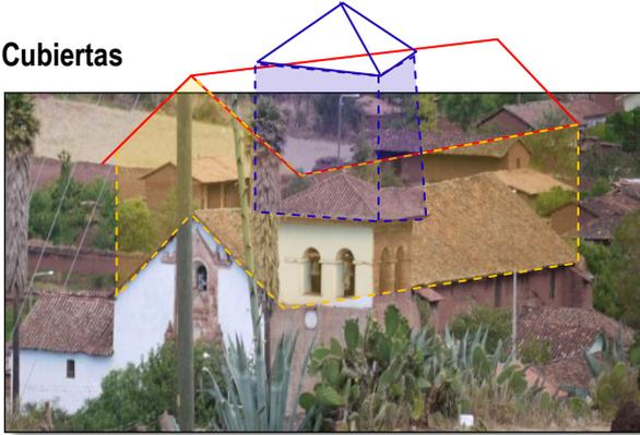
Presenta una sola estructura siendo la diferencia de nivel cero entre la nave y el presbiterio los faldones de cubierta tienen continuidad entre todo el conjunto, a diferencia de los espacios adosados los cuales se hallan a un nivel inferior y en forma transversal a la estructura central.
