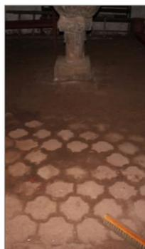
Presenta piso es de losetas de piedra, el revestimiento en muro está completamente degradado.
