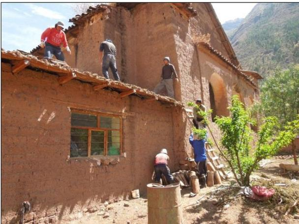
VISTA DE LOS TRABAJOS DESMONTAJE DE CUBIERTA DE TEJA SIN ESTRUCTURA DE LA CONSTRUCCIÓN CONTEMPORÁNEA ANEXA AL MURO DE LA EPÍSTOLA
