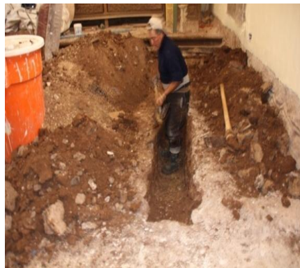
Excavación de zanjas de 0.60 de ancho x 0.40 de profundidad, utilizándose en la base piedra chancada de \frac{3}{4} para posteriormente colocar los tubos cribados en un 50% de 4" x 5 m. Con la finalidad de controlar la presencia de humedad.
