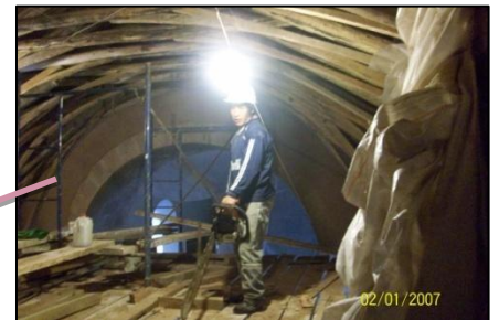
Vista del armado de cobertura de madera
