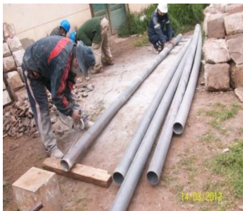
(Preparación de tubos pvc sap de 4" x 5m.
