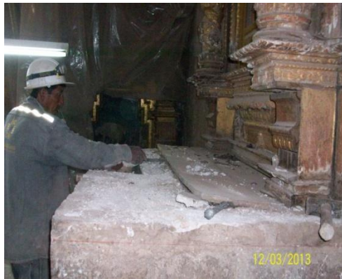
DESMONTAJE, CONSOLIDACIÓN DE SOTABANCO Y ASENTADO DE LADRILLO PASTELERO EN MESAS.
