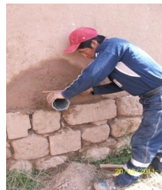
Excavación de zanjas de 0.60 de ancho x 0.40 de profundidad, utilizándose en la base piedra chancada de \frac{3}{4} para posteriormente colocar los tubos cribados en un 50% de 4" x 5 m. Con la finalidad de controlar la presencia de humedad.
