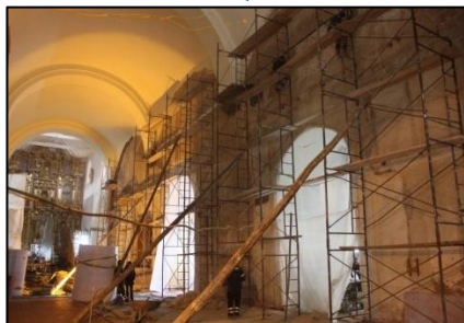
procesos del lijado y masillado (mezclade imprimante con tiza) en los laterales de la nave principal
