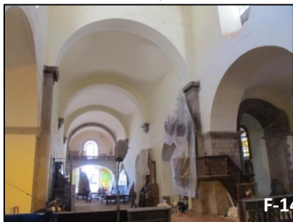
Acabados en bóvedas intradós en la nave principal con pintura vinilica.
