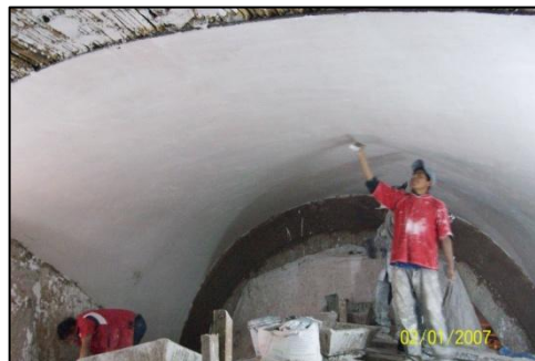
Vista de los trabajos de encarrizado en bóvedas intradós y enlucido de yeso en las mismas.
