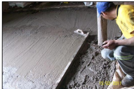
Falso piso de concreto cemento arena 1:5 previo nivelado y apisonado de suelo.
