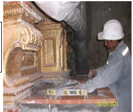
DESMONTAJE, CONSOLIDACIÓN DE SOTABANCO Y ASENTADO DE LADRILLO PASTELERO EN MESAS.
