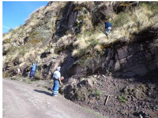
Eliminación de elementos sueltos livianos (desquinches) para el corte de rollizos y para la explotación de piedra en cantera
