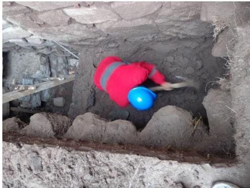
Excavación de zanjas para calzadura de cimientos
