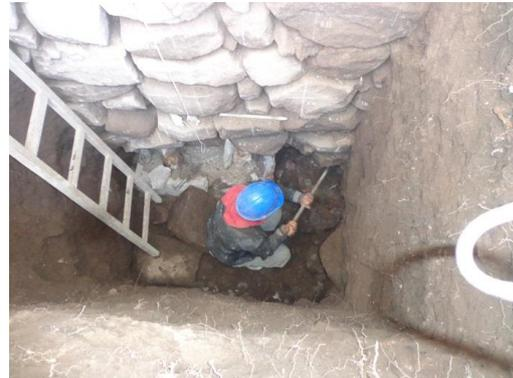
**CALZADURA DE CIMIENTOS CORRIDOS DE PIEDRA CONTRAFUERTES (mortero = cemento - cal - arena)**
