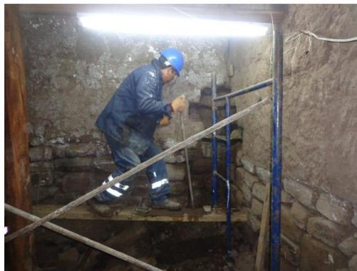
**CALZADURA DE SOBRECIMENTOS DE PIEDRA CONTRAFUERTES (mortero = cemento - cal - arena)**
