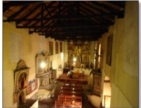
Interiormente está constituido por una nave alargada y sencilla en su tratamiento arquitectónico, los muros están construidos bajo el sistema adobe, delimitado por una grada del presbiterio y una estructura de piedra con tres arcos que definen el sotocoro.
