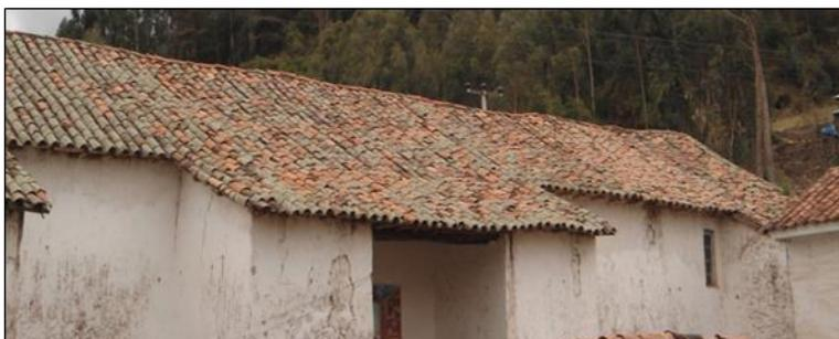
Presenta una sola estructura la diferencia de nivel es cero entre la nave y el presbiterio los faldones de cubierta tienen continuidad entre todo el conjunto y los contrafuertes formando una unidad.
