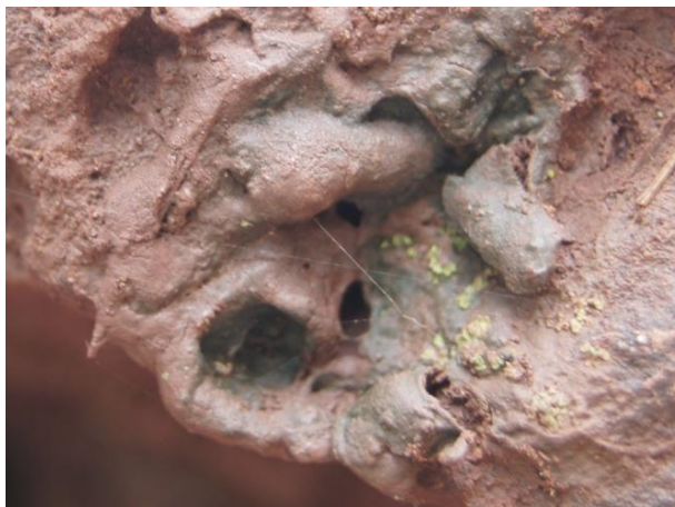
Colonización del mortero en zona lateral exterior del recinto 4. Especie de algas verde-azules del género Oscillatoria .
