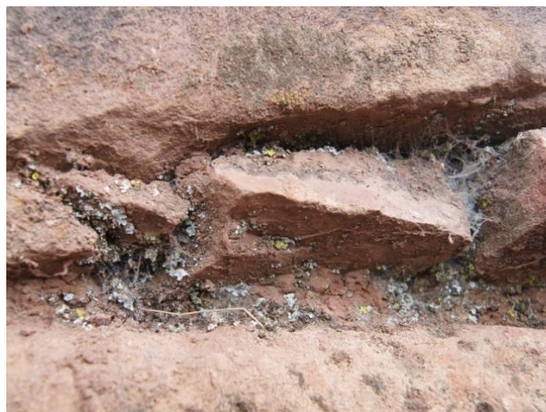
Foto..Colonización de líquenes en el mortero, especies del género Physcia iniciando la invasión.
