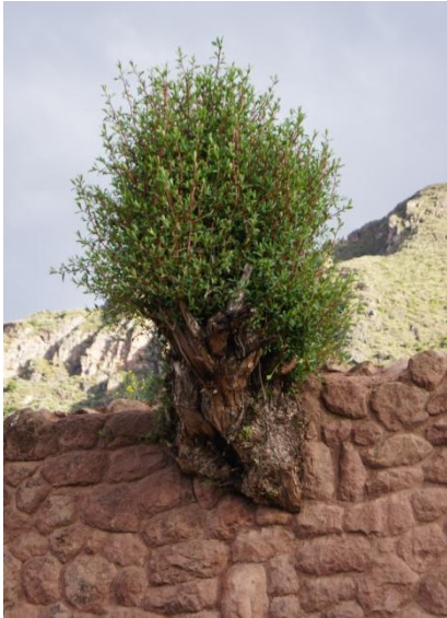
Chachacomo ( Escallonia resinosa ), formando parte de la estructura del muro del andén.
