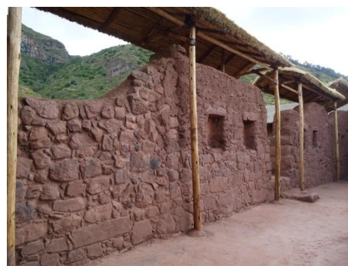
F.18.- (R4-b): Vista muro sur interior con la consolidación de muros de piedra y cubierta de protección.
