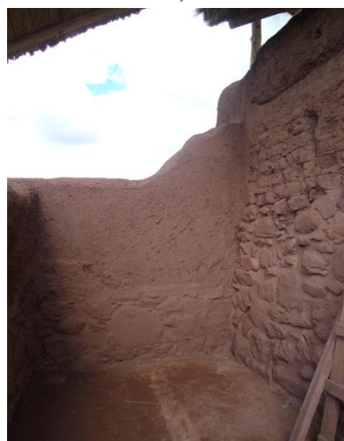
F.14.- (R4-a): Vista interior muro este calzada de muro de adobe y revestimiento con embarre de mortero tierra-arcilla, qigantón con cubierta de protección.
