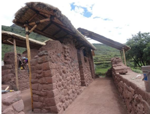
F.09.- (R4-a): Muro medianero vista interior de la cara sur del Recinto 4a donde se realizaron los trabajos de consolidación en muros de aparejo de piedra.
