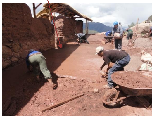
F. 24.- (EA4): Tratamiento de piso contiguo al recinto 04 con mortero de tierra, arcilla, cemento, arena y grava.
