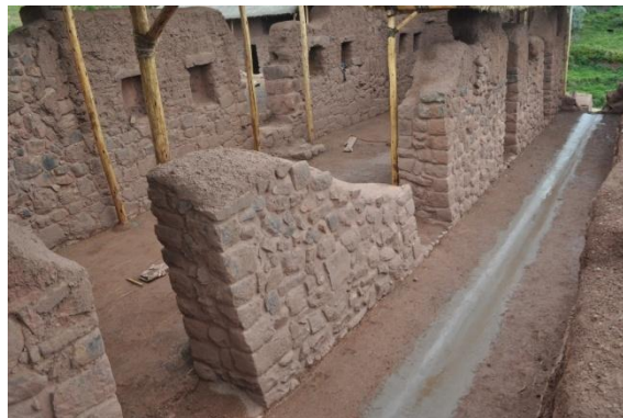
F. 25.- Recuperación de la estabilidad de estructuras en el Recinto 4.
