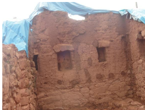
F.16.- (R4-b): Vista muro este se realizaron los trabajos de calzadura de muro de adobe.
