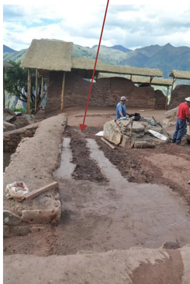
F. 23.- (EA4): Tratamiento de piso contiguo al recinto 01 con mortero de tierra, arcilla, cemento, arena y grava.
