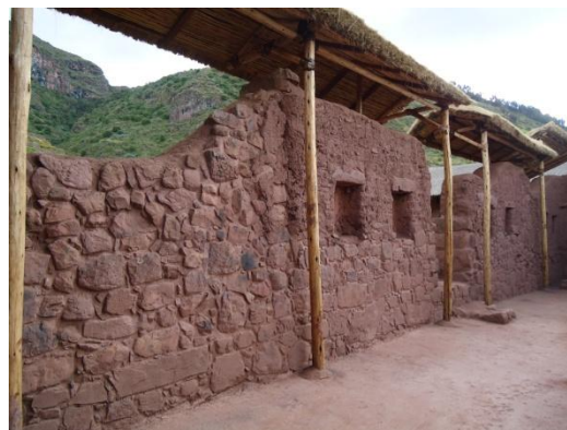
F.22.- (R4-b): Vista interior muro Sur con cubierta de protección, consolidación y emboquillado en paramento.
