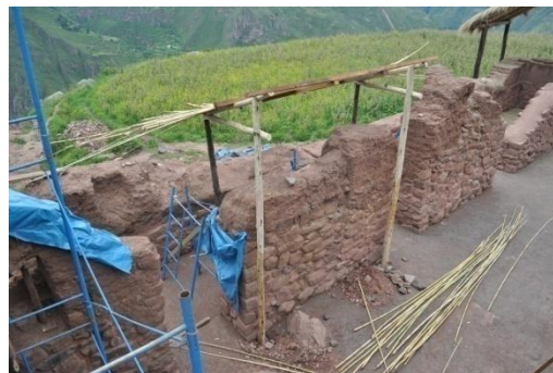
F.15.- (R4-b): Vista de la parte superior del muro norte en el que se realizaron los trabajos de consolidación, restitución, recomposición y tratamiento de cabecera de muros.
