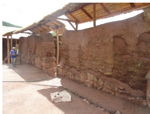
F.17.- (R4-b): Vista muro sur con la consolidación de sobrecimientos y muros de piedra.
