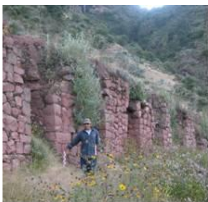
02.- Estructuras Inka inicial en el sub sector B, se nota la pérdida de dinteles en las hornacinas, los que según la Arlga. Maritza Rosa, eran de aliso
