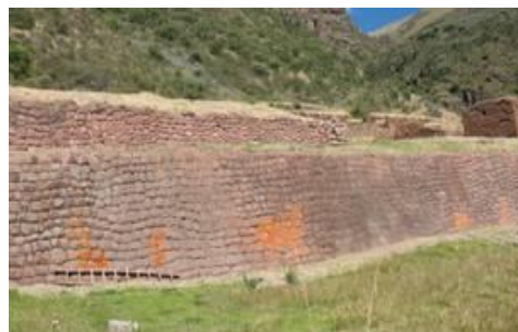
03.- Muro de contención en el sector A de Kajya Kawana, con mampostería de estilo celular
