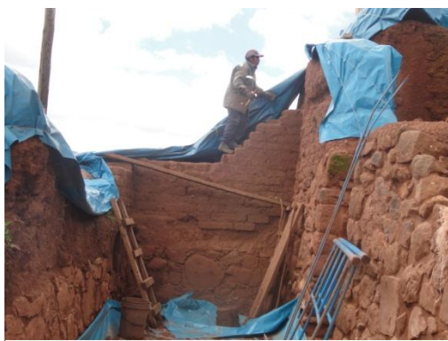
F.10.- (R4-a): Muro este vista interior donde se realizaron los trabajos de consolidación en muros de aparejo de piedra y restitución en muros de adobe.
