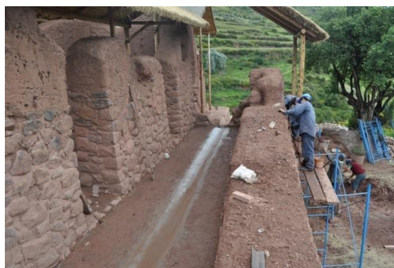
F. 27.- Tratamiento de cabecera de muro en Recinto R4 y revestimiento con embarre.
