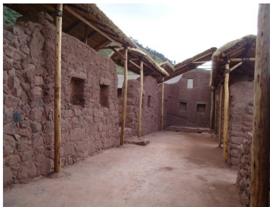
F. 28.- Cubiertas de protección acarteladas en los muros Sur, Medio del Recinto R4.
