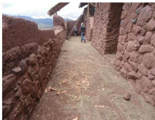
F.08.- (R4-a): Véase a la izquierda el muro norte vista interior donde se realizaron los trabajos de consolidación en piedra y restitución en adobe.
