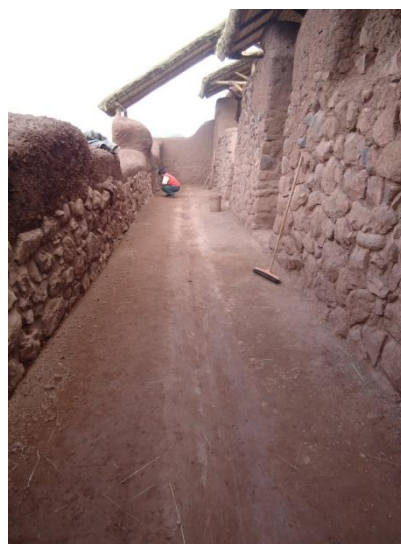
F. 30.- Tratamiento de piso con mortero cemento-arena y gravilla del Recinto R 4a y cuneta central como medio de evacuación de aguas pluviales.
