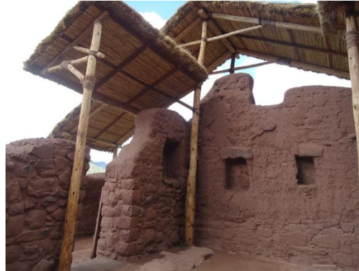
F.20.- (R4-b): Vista interior muro Este se realizaron trabajos de calzadura en adobe por fisuras verticales en nichos y cubierta de protección para hastial.
