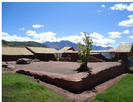
F. 29.- Cubertinas de protección en muro perimétrico Espacio Abierto EA 1.
