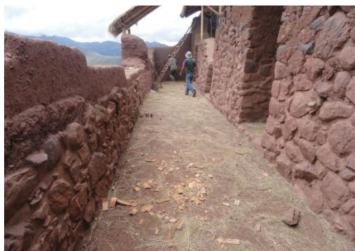
F.12.- (R4-a): Vista interior a la izquierda muro norte con la restitución en adobe y a la derecha consolidación en paramento de piedra.
