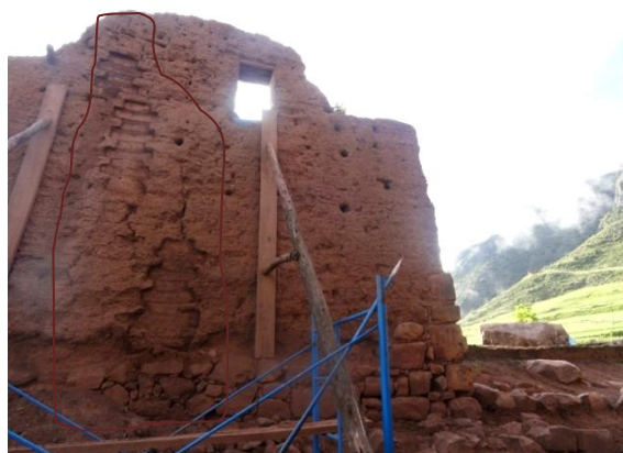
F. 26.- Calzadura de muros de adobe en hastiales en el recinto 04.
