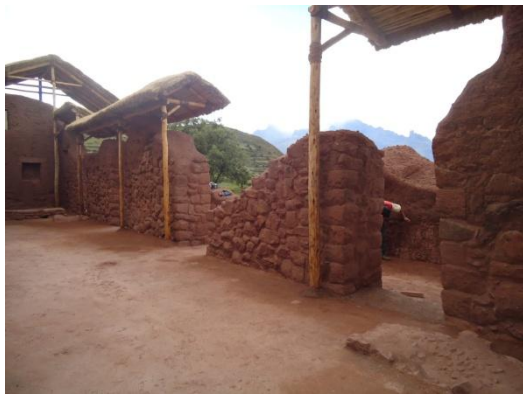
F.19.- (R4-b): Vista muro norte interior con la consolidación de muros de piedra, recomposición, emboquillado y cubierta de protección en los tramos 1, 2, 4, 5 del muro.
