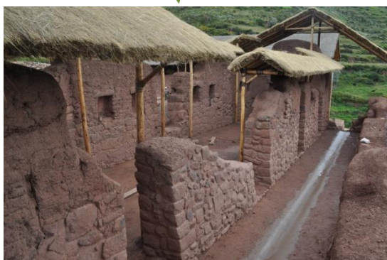
F.13.- (R4-a): Vista interior muro sur con cubiertas de protección acartelada v cubertinas de protección en el tramo 2.
