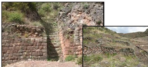
construida con andesita de junta seca unido con mortero de barro bastante delgada, articulado este detalle se encuentra escalinatas de piedra que esta ascendiendo hacia el interior del sub sector.
