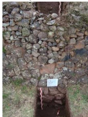
Foto N° 51 A pie de muro la fundación del andén se encuentra pandeado
