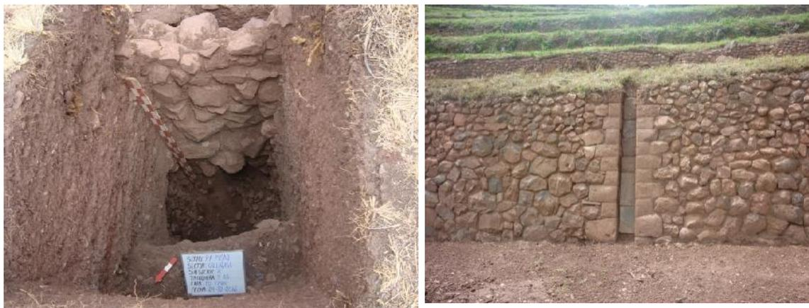
Foto N° 15,16 Vista del registro del tras muro de la estructura del andén donde se registra la estratigrafía del tratamiento constructivo, evidencia del paramento del andén después de la puesta en valor con el canal vertical recuperado con todas sus características.
