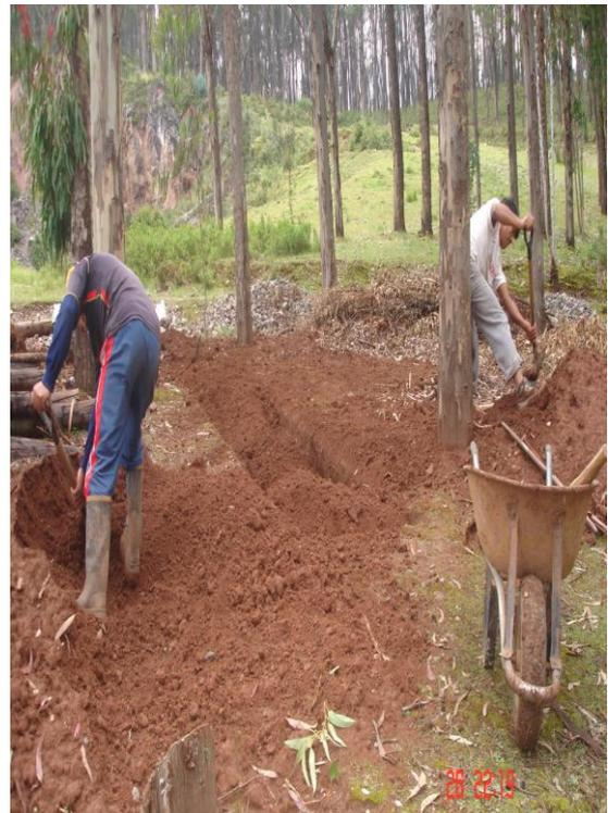
FOTO. 18.- Relleno con material propio de las trincheras excavadas.
