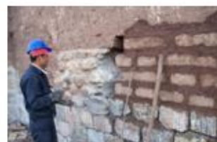
Calzadura de muro de adobe en base el muro evangelio.
