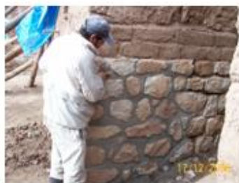
emboquillado de sobre cimiento del muro de
