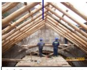
Restitución de estructura de pares en techo de sector de la nave
