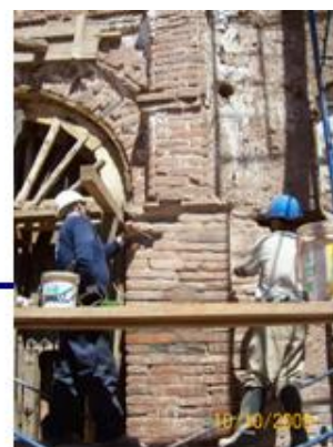
consolidación de portada de ladrillo del muro de pies.
