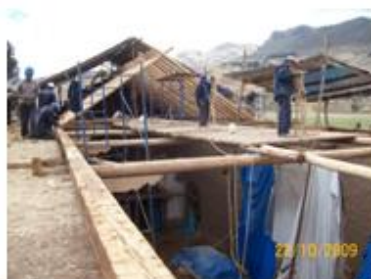
Colocación de amocables y tirantes en sector de la Nave del Templo
