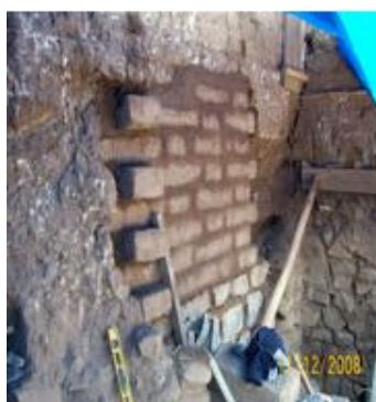
CALZADURA DE BASE DE MURO DE ADOBE, EN LA PARTE EXTERIOR DEL MURO DE LA EPISTOLA SECTOR NAVE.
