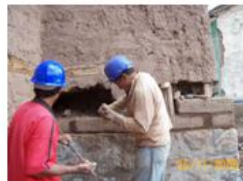
Liberación y calzadura de muro con adobe en base del contrafuerte de adobe.
