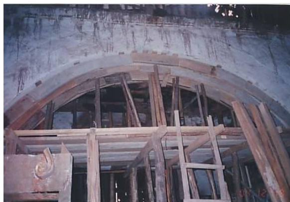
ESPACIO DEL SOTOCORO (Armado del Apuntalamiento)
