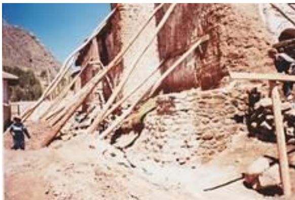
FACHADA LATERAL EVANGELIO (Intervención calzadura de cimentación)
