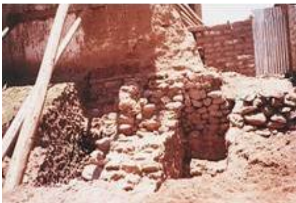
FACHADA LATERAL EVANGELIO (Intervención calzadura de cimentación)
