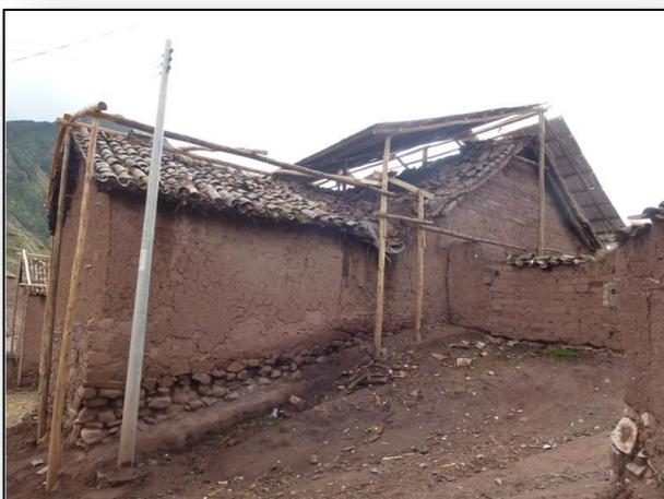
Vista de la parte posterior del templo donde se muestra la estructura de la cubierta provisional de la sacristía y del presbiterio en proceso de techado
