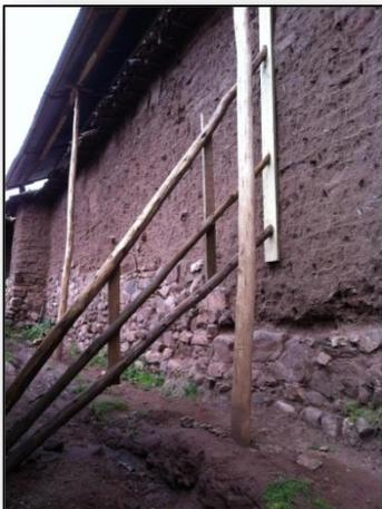
Vista de los apuntalamientos realizados en el muro del evangelio y la protección de la base del contrafuerte y gradería lateral con teja
