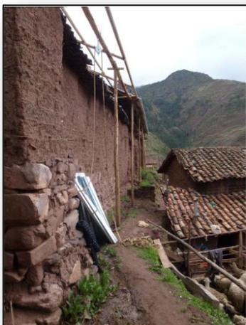
Vista lateral del lado del evangelio donde se muestra la estructura provisional de la cubierta y en la segunda foto la cubierta concluida
