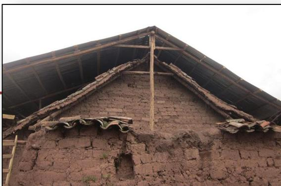
originando filtraciones de aguas pluviales al interior, con respecto a la nave principal la estructura de techo en este sector presenta ligera deformación de su estructura.
