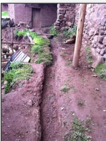
Vista de los trabajos de apertura de zanja para canal de evacuación de aguas pluviales
