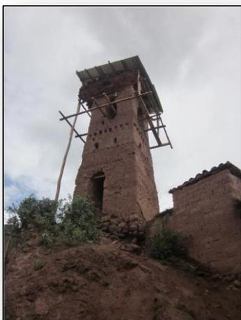
Vista de la plataforma construida en la torre exenta para que soporte la cubierta provisional de calamina, en la segunda imagen se muestra la cubierta provisional construida para proteger la base de la torre exenta
