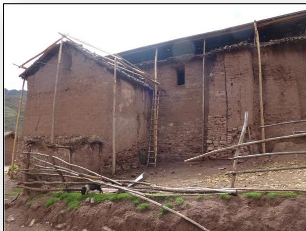
Vista del baptisterio donde se muestra el armando la estructura de madera que soportara la cubierta provisional de calamina
