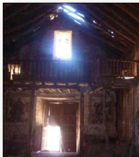
Este espacio inicialmente de forma rectangular ha sido modificado por la ampliación del coro alto cuya planta adopta la forma de "L" por lo cual el sotocoro adquiere la misma forma teniendo que adicionar un tronco que soporte dicho volado a manera de pie derecho el cual descansa sobre una base mayor o plinto de forma circular construido con mortero de barro. Estas columnas conservan en ciertos sectores una decoración con pintura muraria policromática en la gama de verdes y ocre
