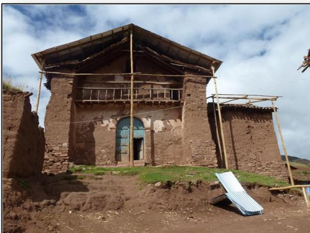
Vista de la fachada principal donde se muestra la cubierta provisional de la nave y la estructura de la cubierta del baptisterio
