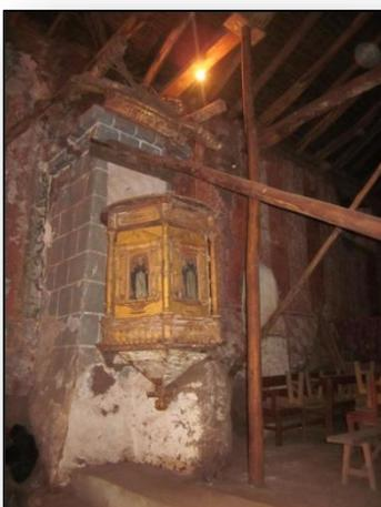
Vista del apuntalamiento de la pilastra del arco triunfal, en la misma imagen se puede ver el apuntalamiento del tirante, en la siguiente foto se muestra los apuntalamientos realizados en el muro de la epístola
