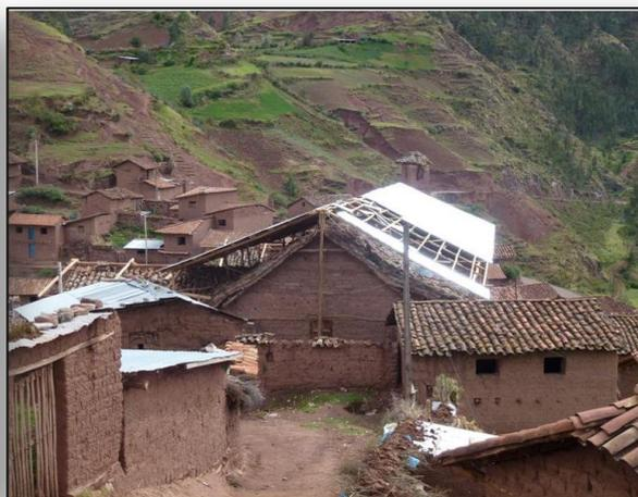
Vista de la cubierta provisional de calamina, en proceso de techado
