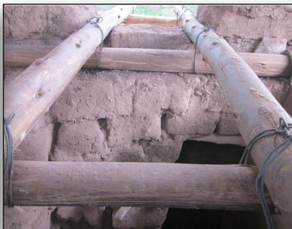
Vista de las vigas utilizadas para la construcción de la plataforma de la torre exenta
