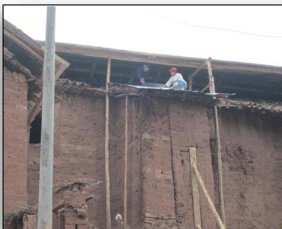
Vista del armado de una cubierta provisional de calamina para proteger el primer contrafuerte del muro de la epístola, se muestra además el puntal colocado bajo el alero
