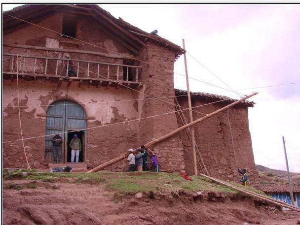
Vista de la fachada principal del templo, en la imagen se muestra el proceso de izado de pies derechos que soportara la cubierta provisional de calamina.
