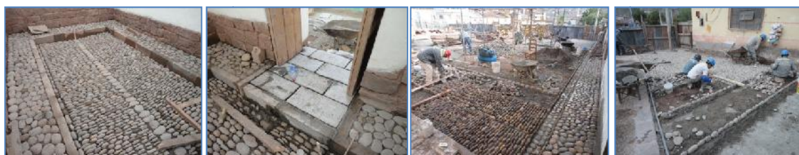
Foto (74-75-76-77) Vista de los trabajos de restitución de piso de canto rodado en lado exterior del muro del evangelio y atrio principal.
