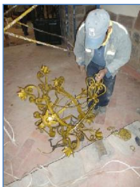
Foto (96-97-98-99) Vista de los trabajos de instalación de arañas pequeñas (08 focos) en capillas laterales del monumento.
