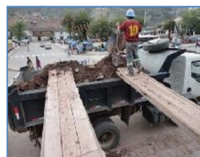
Foto (58-59-60-61) Vista de los trabajos de eliminación de desmonte del atrio principal mediante la utilización de volquete de la DRC-C y herramientas manuales.
