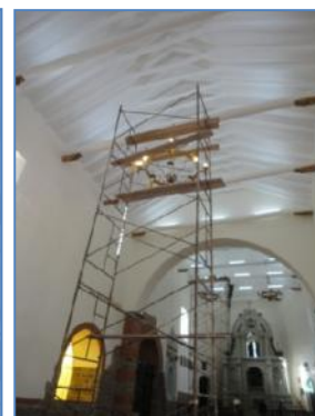
Foto (96-97-98-99) Vista de los trabajos de instalación de arañas pequeñas (08 focos) en capillas laterales del monumento.
