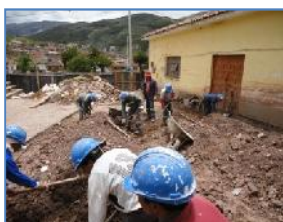
Foto (58-59-60-61) Vista de los trabajos de eliminación de desmonte del atrio principal mediante la utilización de volquete de la DRC-C y herramientas manuales.
