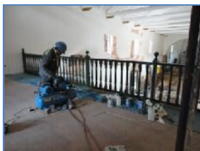
Foto (82-83-84-85) Vista de los trabajos de pintura en carpintería de madera (color verde colonial).
