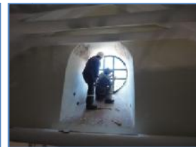
Foto (52-53-54-55) Instalación de vidrios en vanos de la nave y capillas laterales
