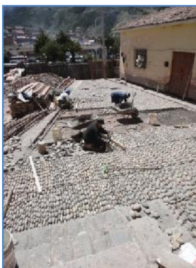
Foto (93-94-95) Vista de los trabajos de restitución de piso de canto rodado, así como el canal colector de aguas pluviales en atrio principal para su posterior fraguado.
