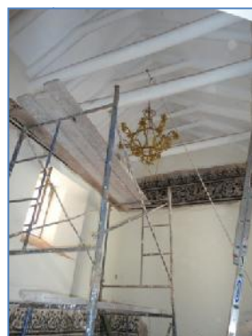
Foto (96-97-98-99) Vista de los trabajos de instalación de arañas pequeñas (08 focos) en capillas laterales del monumento.
