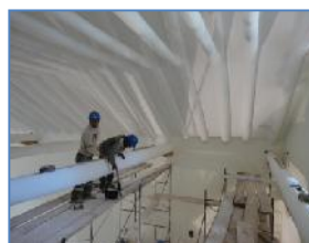
Foto (56-57) Vista de los trabajos de cableado e instalación de fluorescentes lineales en tirantes del a nave altura del coro.
