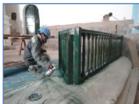
Foto (82-83-84-85) Vista de los trabajos de pintura en carpintería de madera (color verde colonial).
