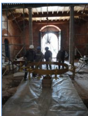
Foto (96-97-98-99) Vista de los trabajos de instalación de arañas pequeñas (08 focos) en capillas laterales del monumento.
