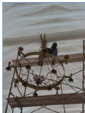
Foto (96-97-98-99) Vista de los trabajos de instalación de arañas pequeñas (08 focos) en capillas laterales del monumento.
