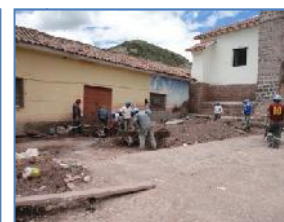
Foto (58-59-60-61) Vista de los trabajos de eliminación de desmonte del atrio principal mediante la utilización de volquete de la DRC-C y herramientas manuales.
