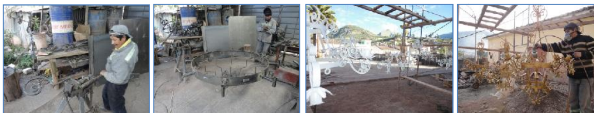
Foto (70-71-72-73) Vista de los trabajos de confección de arañas decorativas, grandes y pequeñas según modelo propuesto y aprobado, con base anticorrosiva y color oro viejo.
